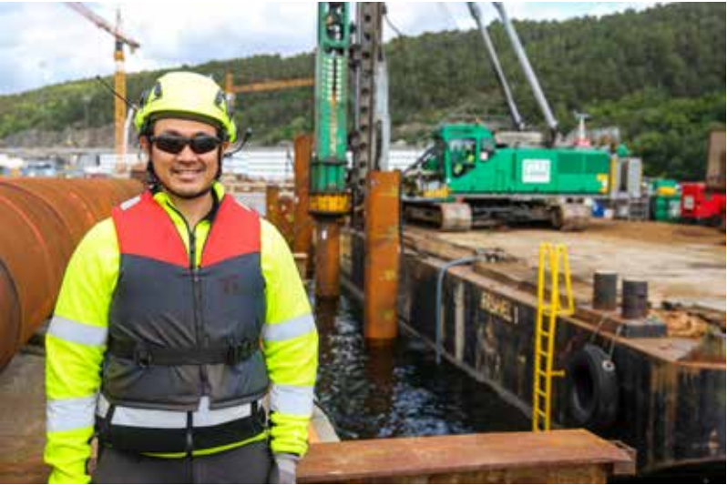
Anleggsleder Saphon Suktamuk i Fundamentering AS (FAS) forteller at de er inne i sluttfasen av pelearbeidene. De har kun 14 peler igjen og satser på å være ferdige før fellesferien.
