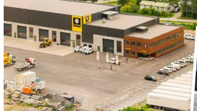
Implenia Norges nye hovedverksted på Dal. (Foto: Implenia)
