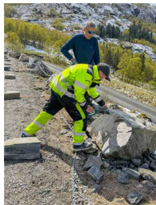
Elevene borer i store steiner for å montere kjetting langs ytterkantene av parkeringsområdet.
