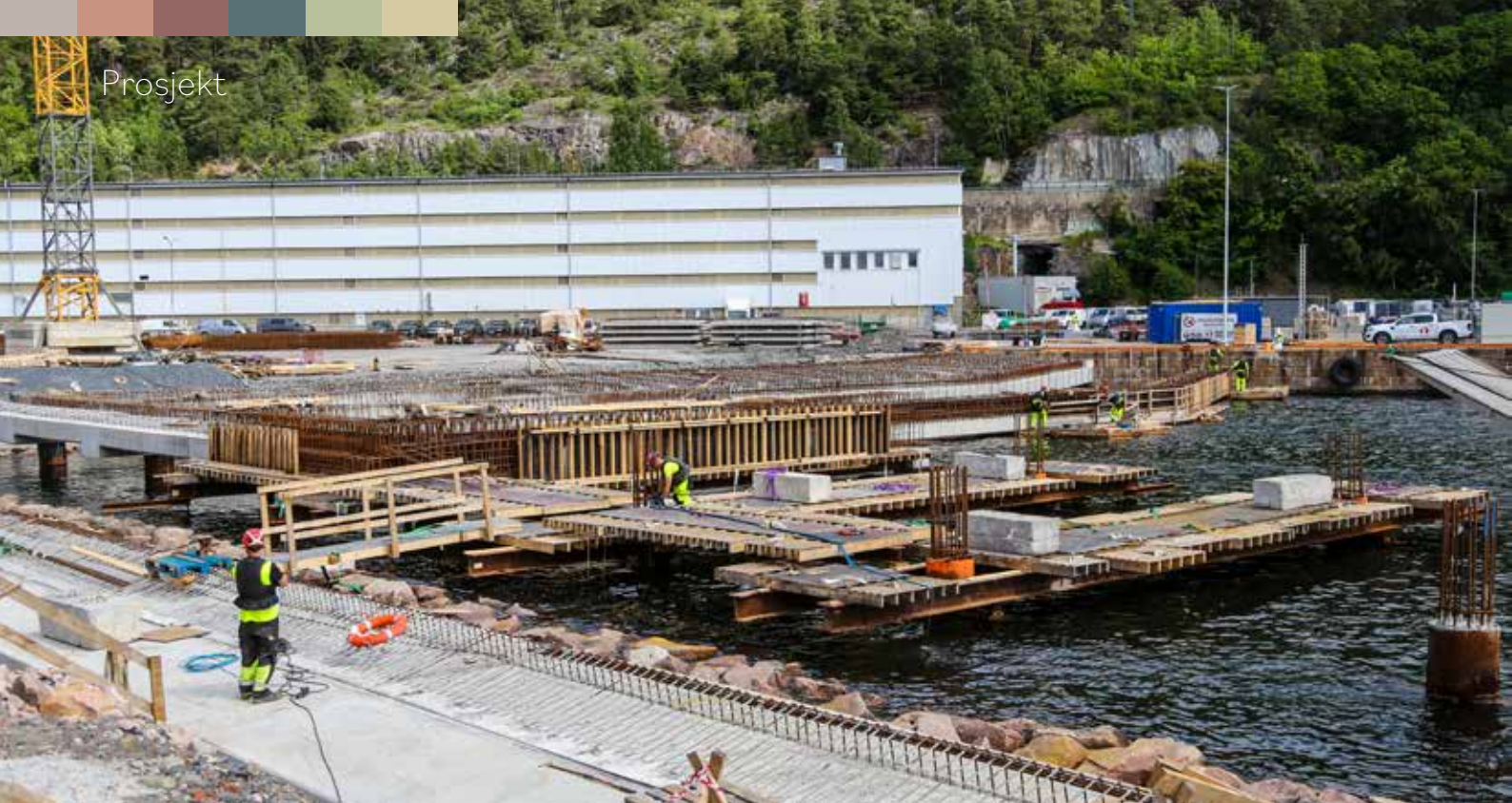
Her etableres den nye og større «ro-ro-kaiaen» (ro-ro står for roll-on/roll-off, som betyr at lasten kan kjøres på hjul direkte av og på skip).
