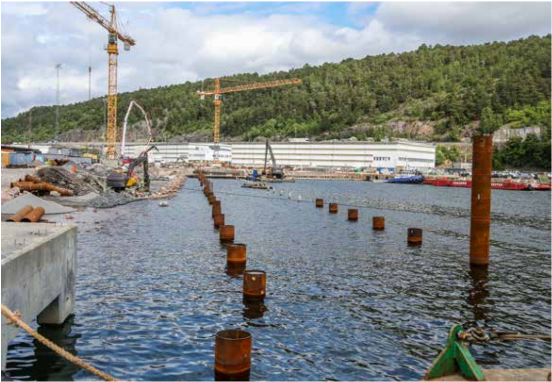
FAS og Repstad Anlegg etablerer en 284 meter lang kaifront, som blir 16 meter bred hele veien.
