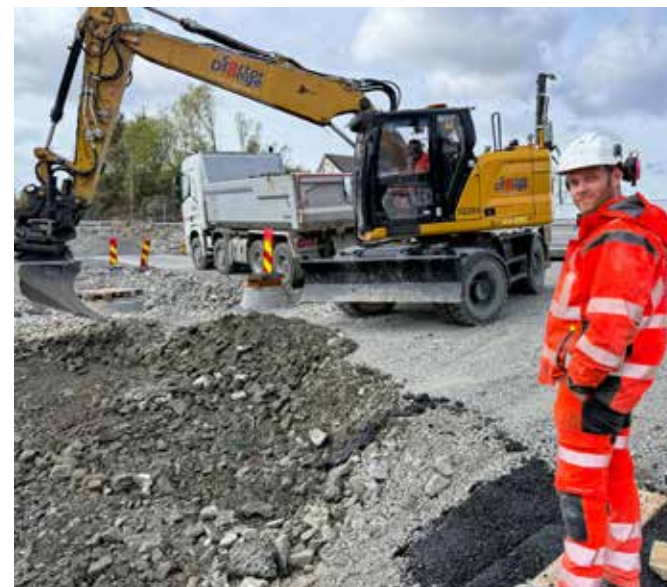
Martin Merkesvik begynte som grunnarbeider hos Sartor & Drange i oktober 2025 og skryter av arbeidsmiljøet. Her passer han på så ikke maskinføreren treffer på kabler som ligger i grunnen.
