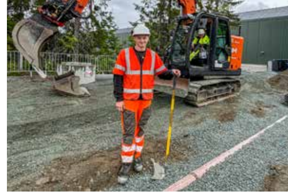
Lærling i anleggsrørleggerfaget Markus Farstad Buland (20), med hjelpemann Bjørn Alstad i maskinen bak.
