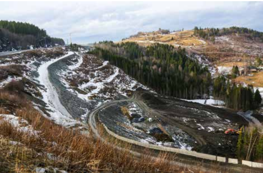
Det er krevende grunnforhold flere steder langs traseen. Her er det et område med kvikkleire, hvor det utføres masseutskifting og forsterking.
