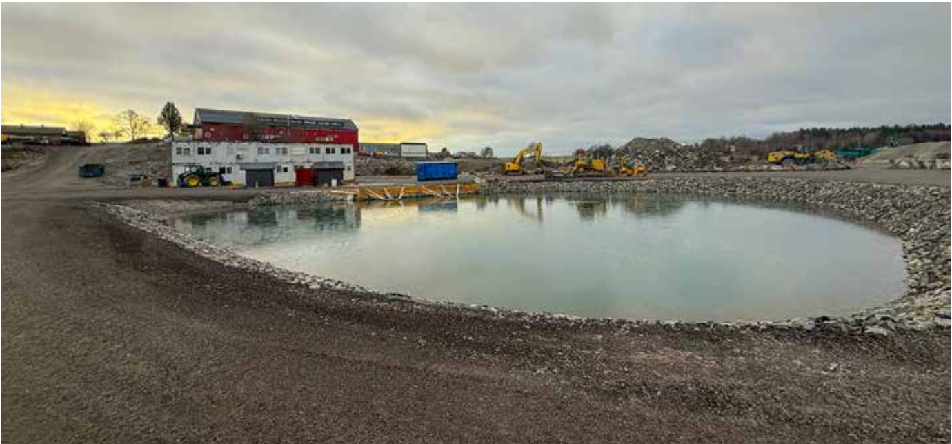
Det er anlagt en sju meter dyp dam på øvingsområdet. Her skal nødetatene ha øvelser knyttet til drukning, redning fra vann og komplekse ulykkes-scenarier. Det røde bygget i bakgrunnen er brannstasjon, ambulansestasjon, kurs- og øvings-senter for blant annet Norsk Luftambulanseteknologi.
