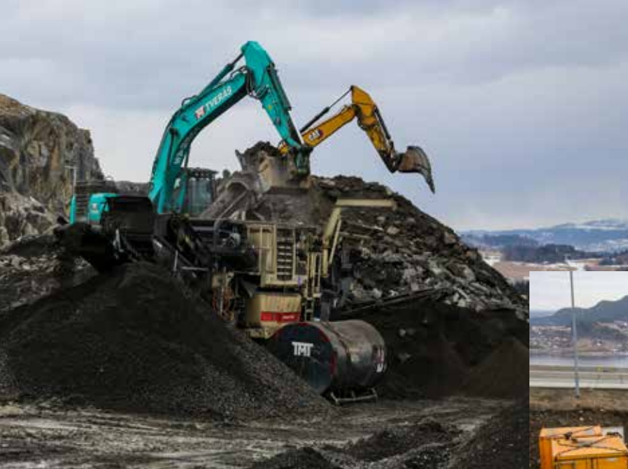
Det meste av eksisterende asfalt knuses og gjenbrukes på prosjektet, ifølge Langeid. Her er knuseverket i aksjon.
