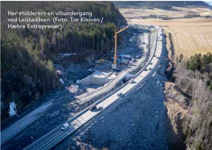
Prosjektet inneholder 30 nye konstruksjoner. Her pågår støpearbeid på en kulvert.
