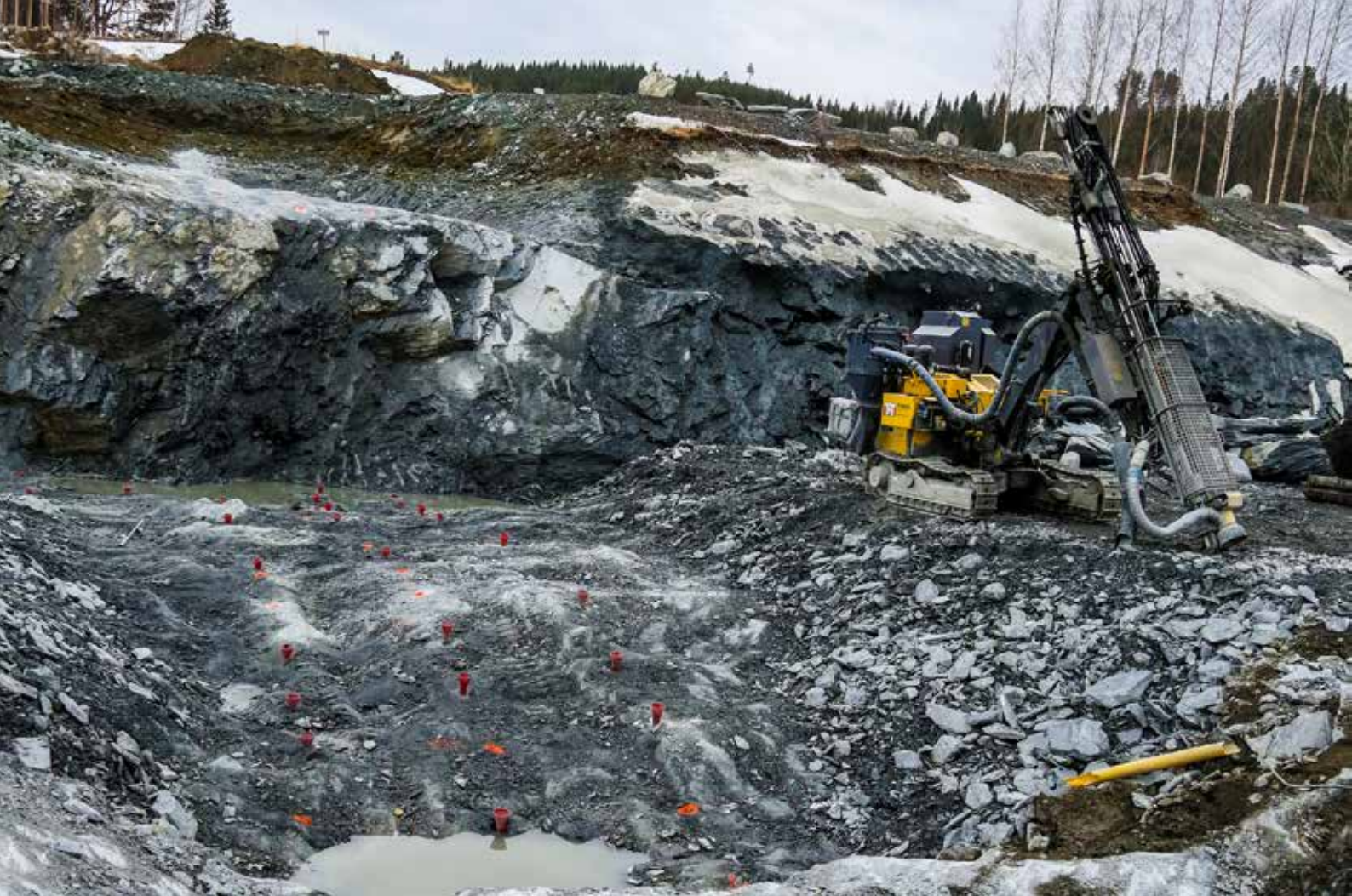
Det foregår mye sprengning på prosjektet, noe som gjør trafikkavviklingen enda mer utfordrende. I forbindelse med hver sprengning, må veien stenges.
