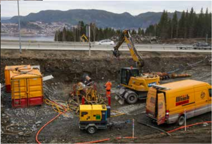
Her foregår såkalt minitunnelering under eksisterende E6. Olimb Anlegg er underentreprenør.
