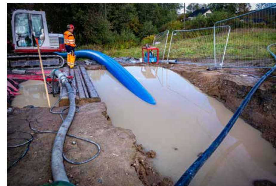
Inntrekking av PE-ledning med PP-kappe på en del av VA på langs.
