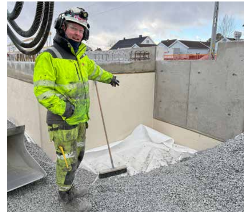
David Stensland er ansatt i Agder Entreprenør, som er leid inn for å utføre selve sprøytejobben. Her viser han hvor de har lagt Eliminator på en betongkonstruksjon
