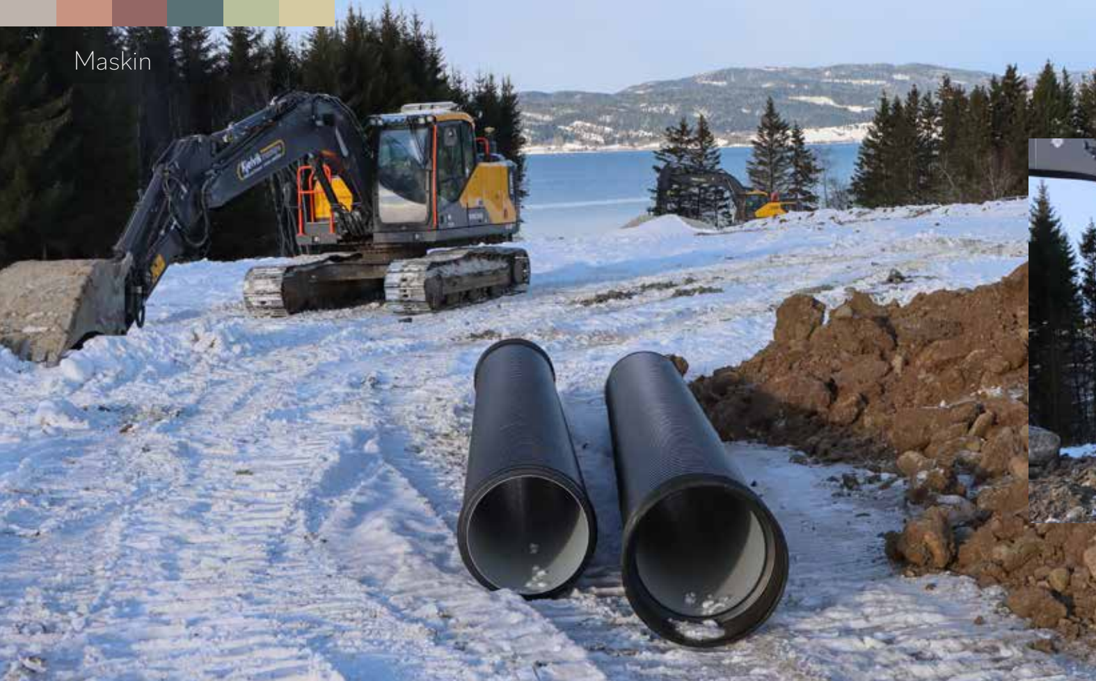
Oppdraget MEF-medlem Kjelvik Maskin AS utfører på nordsiden av Inderøy er et SMIL-prosjekt med legging av overvannsrør, i tillegg nydyrking av 58 dekar. Volvo EC180E-graveren er selskapets andre maskin
