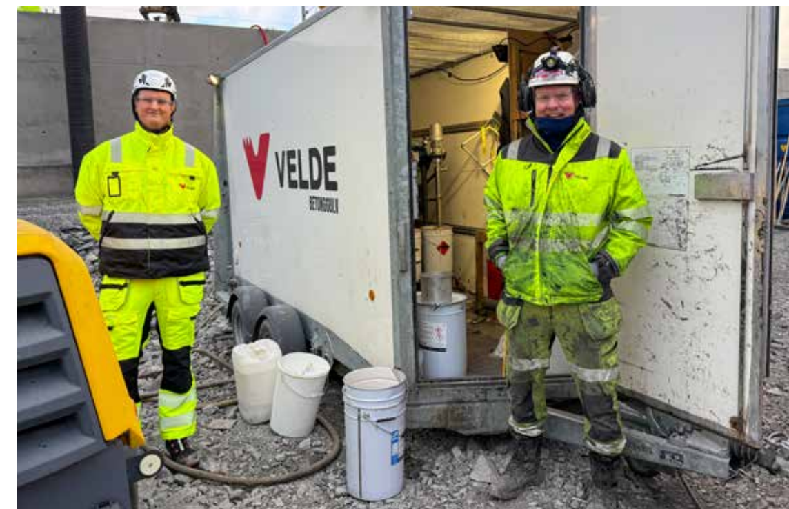
Harald Rosengren (t.v.), Velde Gulv, og David Stensland, Agder Entreprenør, ved tilhengeren som rommer alt av utstyret de bruker for å legge Eliminator.
