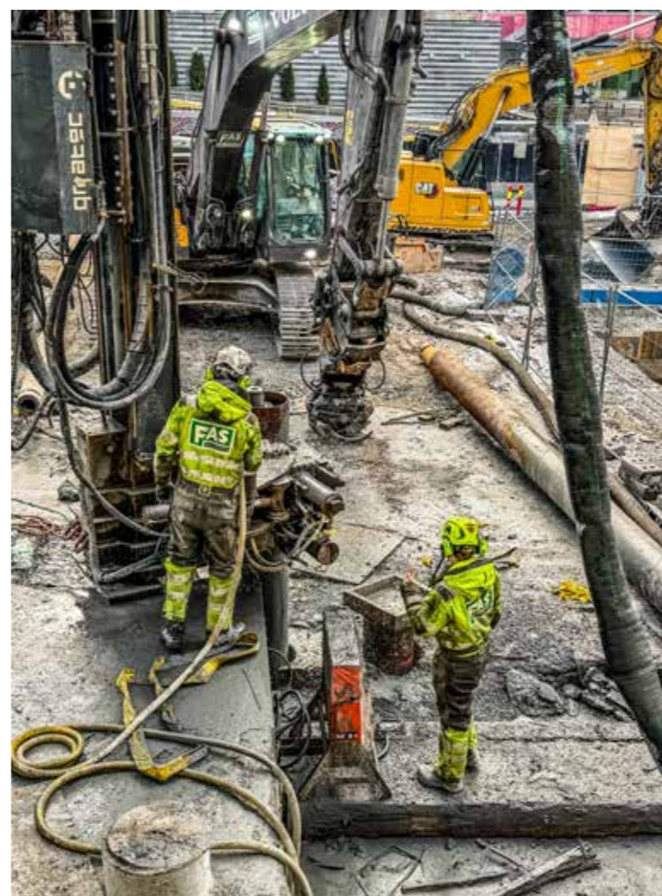
FAS borer ned ca. 135 peler, som alle går ca. 4 meter ned i fjell. Totalt rundt 5000 meter med ståljernepeler.
