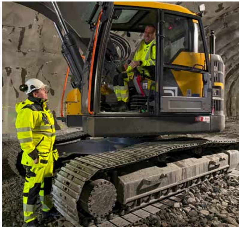
Prosjektingeniør Kasper Håland i samtale med maskinfører Karl Hogne Iden. Korthekkeren Volvo ECR235EL har sikkerhetsruter i alle ruter.
