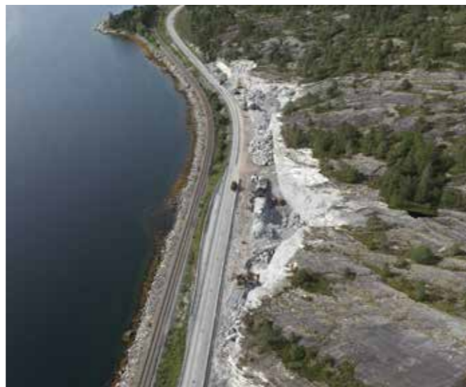
Ytterkleiva er ferdig skredsikret. Nå skal den resterende delen av rv. 80 Sandvika-Sagelva utbedres. Veien er i dag smal, har gjennomgående dårlig kurvatur og det er mange trafikksikre avkjørsler. Det har vært en rekke alvorlige ulykker på strekingen. (Dronefoto: Statens vegvesen)
