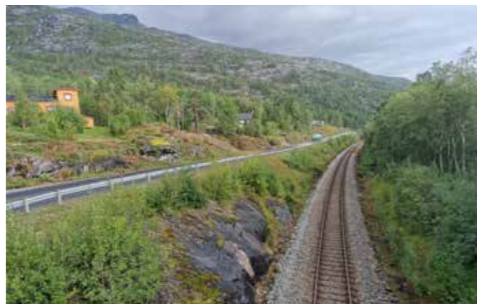
Krevende utbygging: Nærhet til Nordlandsbanen og liten plass mellom skinnegang, vei og bebyggelse gjør utbyggingen mer krevende. (Foto: Statens vegvesen)
