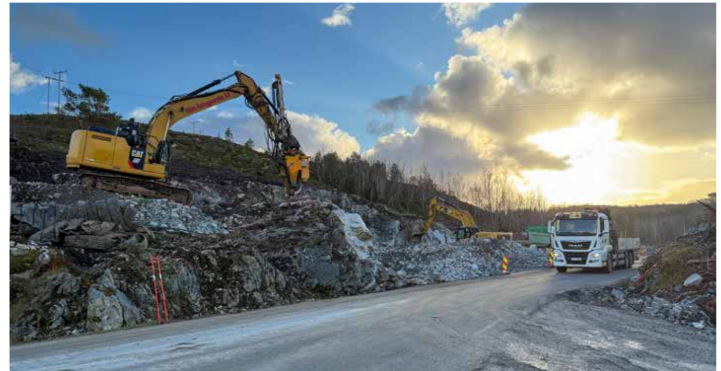
Det er fjell som må sprenges og knuses på stort sett alle prosjektene på Hitra og Frøya. Selskapet har flere boreapplikasjoner for bruk på gravemaskinene, og de har flere bergsprengere ansatt. Her fra prosjektet hvor de bygger ny vei i forbindelse med bygging av ny bro over Knarrlagsundet.
