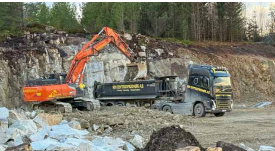
Etter fusjonen har selskapet fått en stor og variert maskinpark. Her opparbeides et nytt næringsområde i Fillan sentrum på Hitra.
