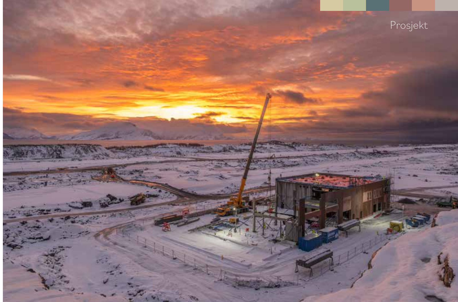
Det har skjedd litt siden Anleggsmaskinen var på besøk. Vinteren har kommet, og det nye plass-, brann- og redningsbygget reises. (Foto: Tor O. Iversen/Avinor)
