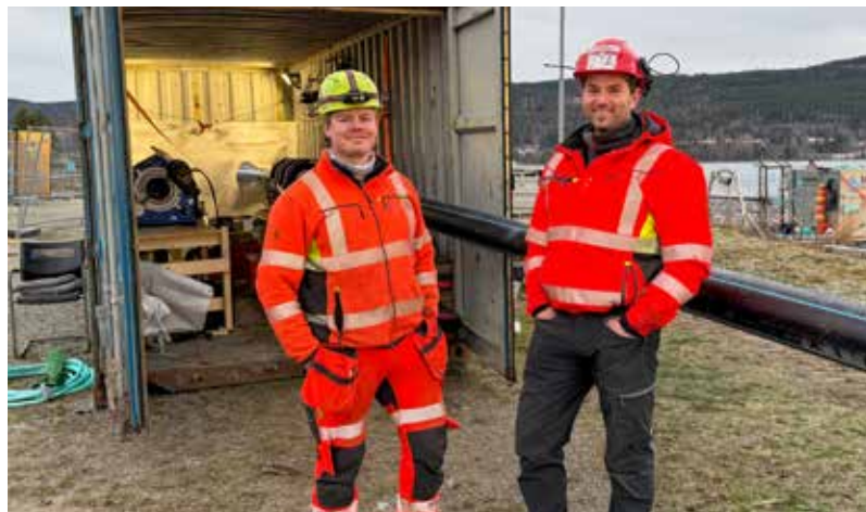
Selv om det er mange ansatte som har jobbet mange år i selskapet, er det stadig yngre som kommer til. Lærling Åsmund Øksenvåg (t.v.) skal ta fagbrev som anleggsrørlegger, og jobber med å sveise sjøledningen. Selskapet har flere slike sveisecontainere og i forskjellige størrelser.
