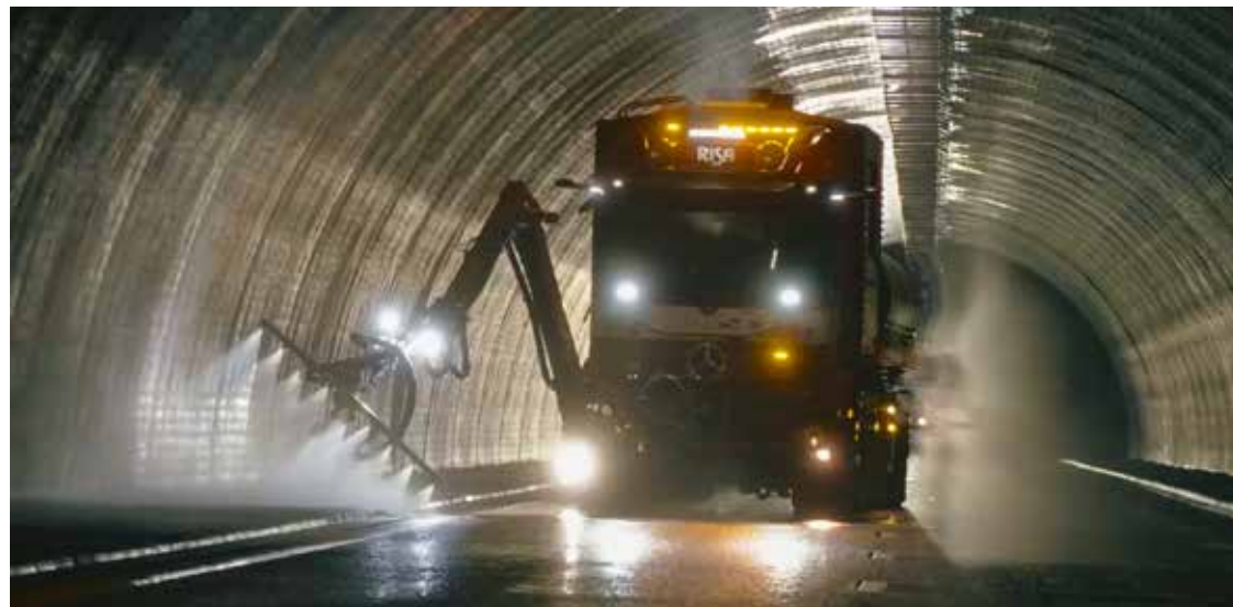
Risa har utviklet ny teknologi som bidrar til mer effektivt tunnelvedlikehold. (Foto: Risa)
