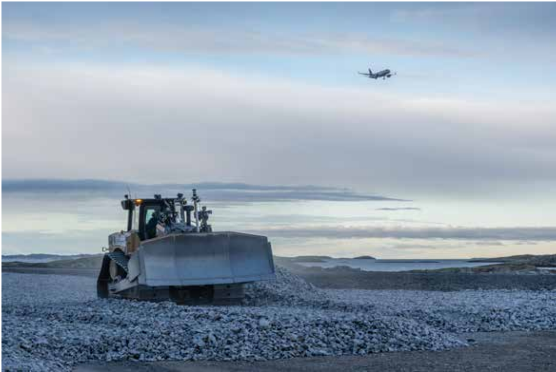
Et fly er på vei inn for landing på Bodø Lufthavn, mens en bulldoser jobber med forsterkningslaget vest på den nye rullebanen. (Foto: Tor O. Iversen/Avinor)
