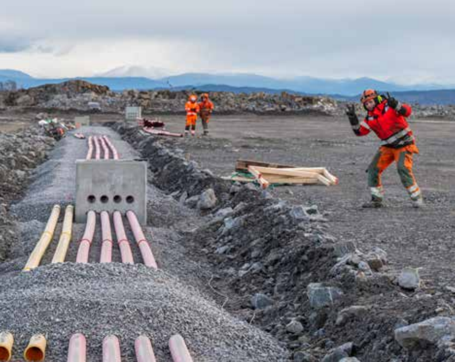
Dette er fra rullebanen i øst, der det legges trekkerør for banebelysning. Arbeiderne er i godt humør. (Foto: Tor O. Iversen/Avinor)
