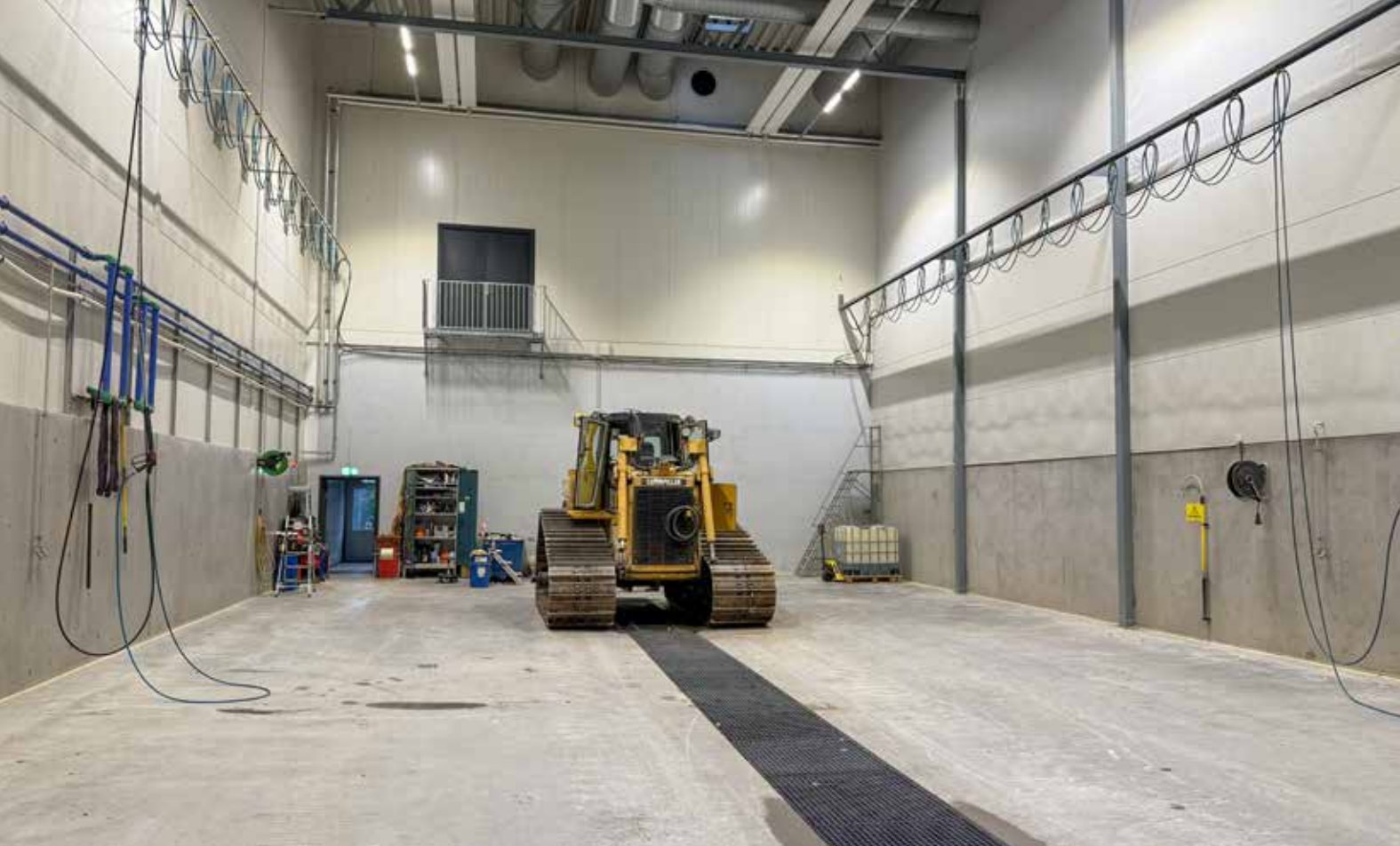
Anlegget har to store vaskehaller.
