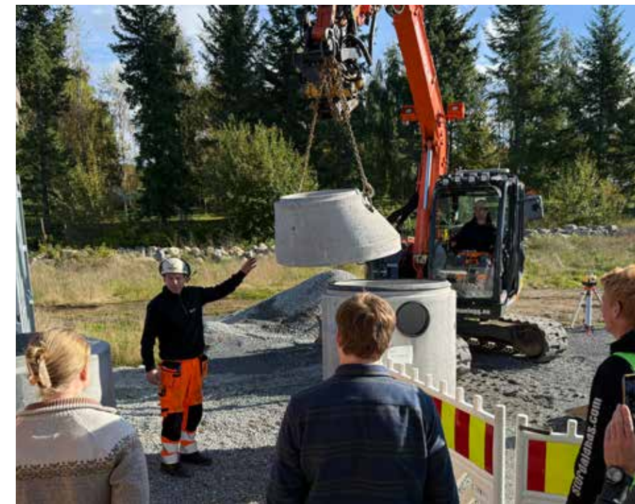
Per-Ivar Nygård hos Fossum Anlegg AS viste og forklarte hvordan man skal legge rør og sette ned kummer, mens maskinfører Tomas Syr utførte jobben
