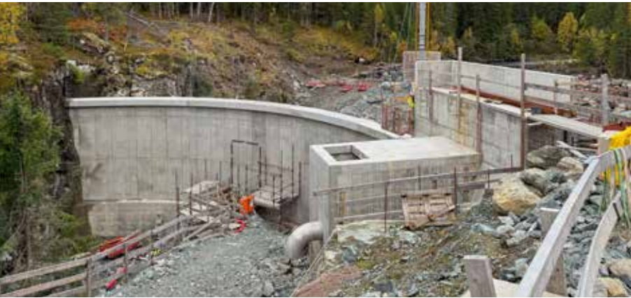
Kraftverk som produserer mer enn 10 megawatt betaler grunnrenteskatt. I statsbudsjettet for 2026 foreslås det å innføre grunnrenteskatt også for småkraftverk som produserer mellom 1,5 og 10 megawatt, slik som dette småkraftverket som er under bygging på Fosenhalvøya i Trøndelag.
