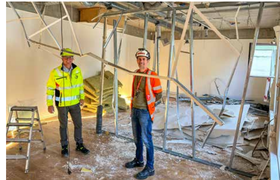
Allerede første dagen etter oppstart, kunne MEFs byggeleder Paul Olaf Baraas (t.v.) og Park & Anleggs prosjektleder Fredrik Johander slå fast at rivingen var godt i gang.
