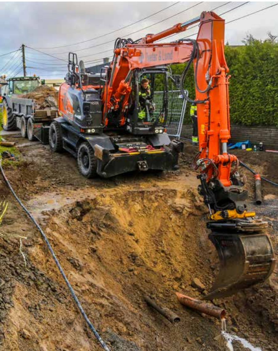
VA-PROSJEKT: Tveter & Lund har mange vann- og avløpsprosjekter, som dette for Larvik kommune.
