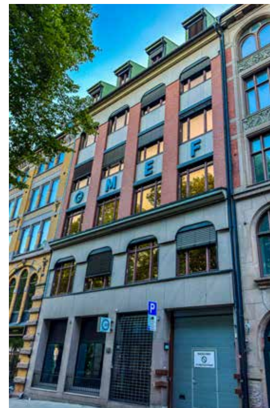
Den seks etasjer høye bygningen, som ble reist i 1982 og tatt i bruk året etter, har tjent MEF godt i over 40 år. Nå står en etterlengtet oppgradering for tur. (Foto: Paul Olaf Baraas)
