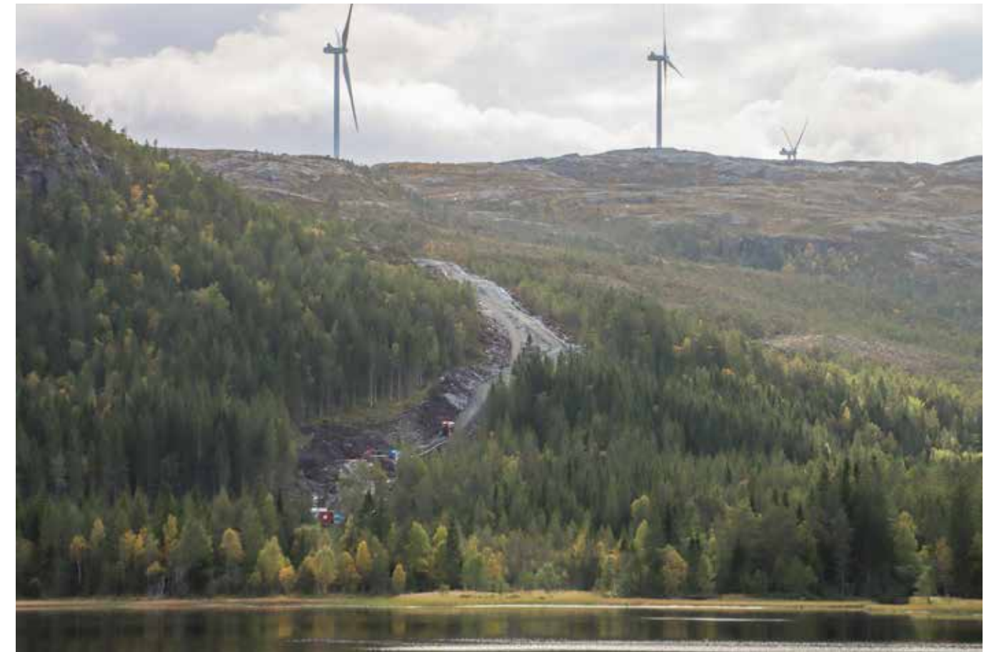
Noen få kilometer utenfor Åfjord sentrum, i nærheten av Storheia vindmøllepark, er Kvekroken Entreprenør i full gang med bygge Grovlia kraftverk. Dette er ett av totalt tre småkraftverk de er i gang med å bygge.
