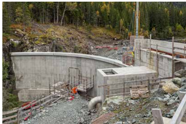
Prosjektet med byggingen av Selja kraftverk overtok Kvekroken Entreprenør etter et annet selskap som måtte gi seg, og de overtok prosjektet i april. Demningen er snart ferdig, og de er i avslutningsfasen med selve kraftstasjonen.
