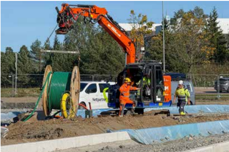
Det nærmer seg ferdigstilling av døgnhvileplassen, og det er få masseforlytningsmaskiner igjen på området. Hitachi Zeron ZE85 blir blant annet brukt til trekking av kabler til belysning og ladestasjoner.
