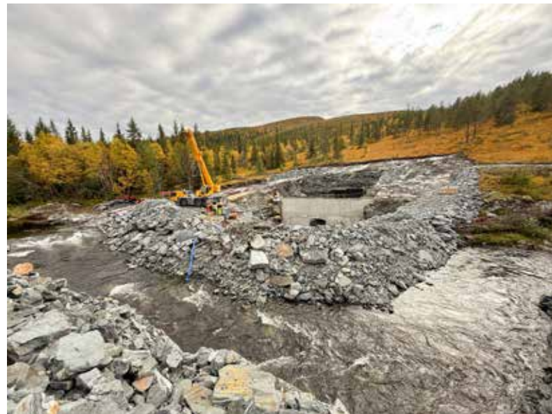
Trongstadlia kraftverk er så langt det største kraftverk-prosjektet til Kvekroken Entreprenør. Her er de i full gang med støping av inntaket til den 1100 meter lange tunnelen som skal lede vannet fra demningen og ned til kraftstasjonen. Tunnelen har en diameter på ca. 20 m 2 .
