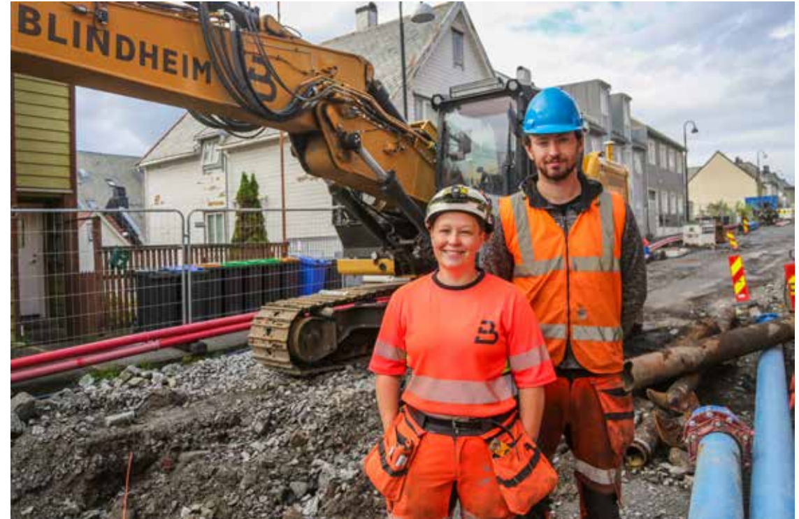
Eline Randi Lilleås Midthjell (32) ble, like før sommeren i år, første kvinne i Møre & Romsdal som tok fagbrev i anleggsrørleggerfaget. Martin Dybvikstrand (24) har tatt fagbrev både i anleggsmaskinførerfaget og fjell- og bergverksfaget. Begge to stortrivdes som lærlinger hos Blindheim Maskin & Transport. – Det er jo en grunn til at vi blir værende her, sier de i kor.
