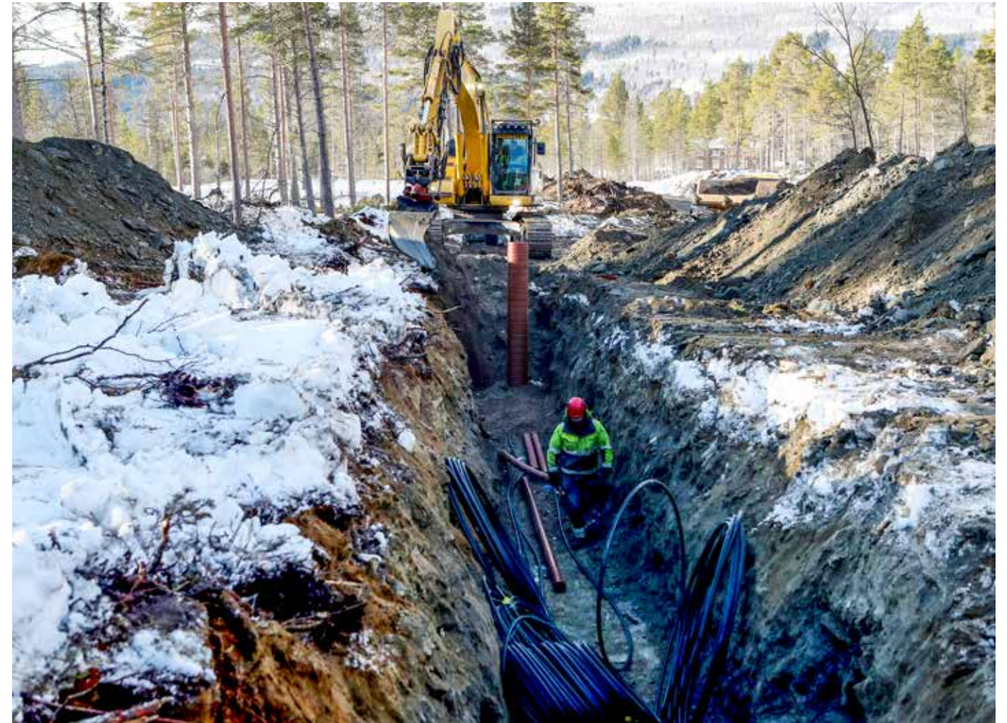
Her jobber maskinfører Sverre Moltu i grøfta og maskinfører og bas Ivan Solheim i gravemaskina på et boligfelt i fjellbygda Vingelen.
