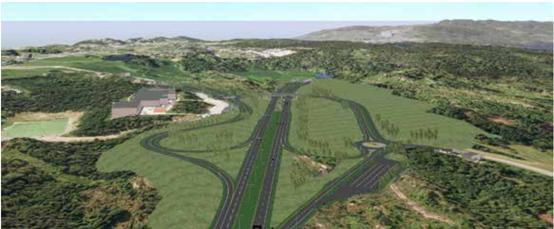
E134 Oslofjordforbindelsen byggetrinn 2 ved Måna, Drøbak. Illustrasjon: Statens vegvesen
