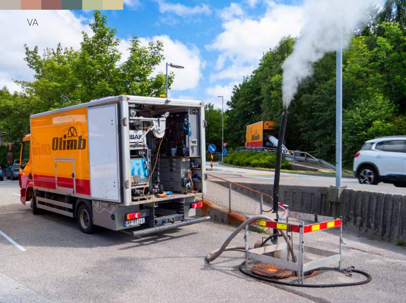
Installasjon av strømpeforing via kum. (Foto: Olimb Rørfornyng)
