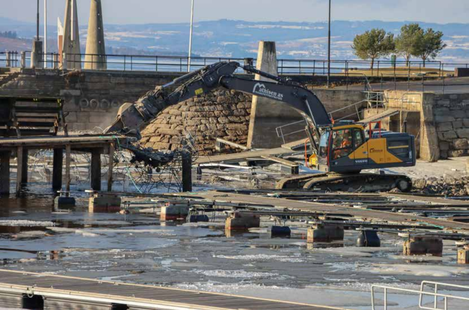
Mathisens Volvo-gravere tygger seg gjennom den gamle bryggen som ble bygget rundt 2. verdenskrig. Høy vannstand i Mjøsa gjør arbeidene litt mer utfordrende.
