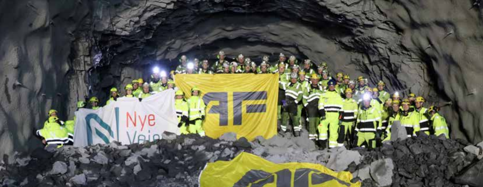
Endelig, etter 14 måneder, er det lys i begge ender av den 2,8 km lange Fåbergstunnelen. (Foto: AF Gruppen)
