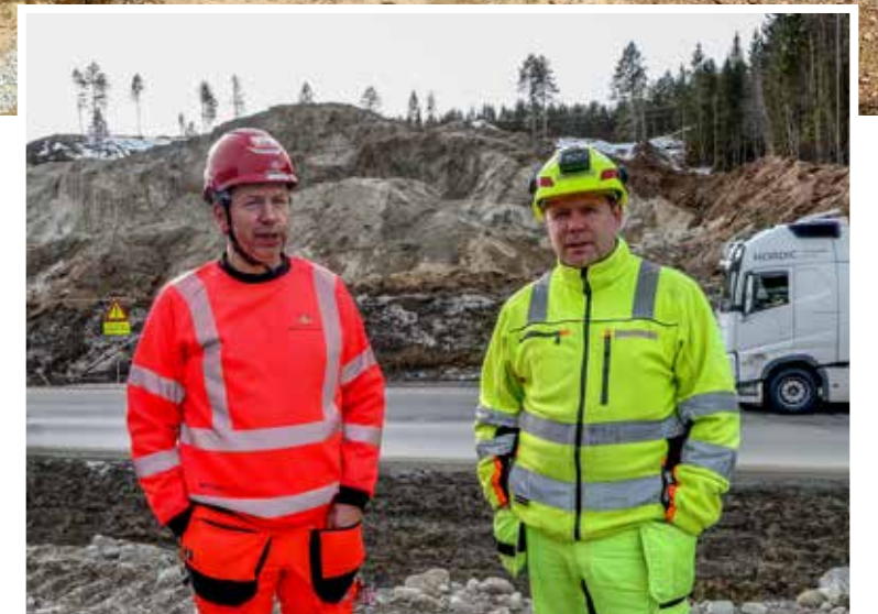
Både Stig Johansen (t.v.) i Statens vegvesen og anleggsleder Frank Mellemstuen i Anlegg Øst Entreprenør er svært godt fornøyd med prosjektet – ny Rv. 3 mellom Evenstad og Imsroa Syd. Den nye veien bygges her inntil dagens Rv. 3 ved Rogner gård. I bakgrunnen ser vi deler av Rogner massetak.
