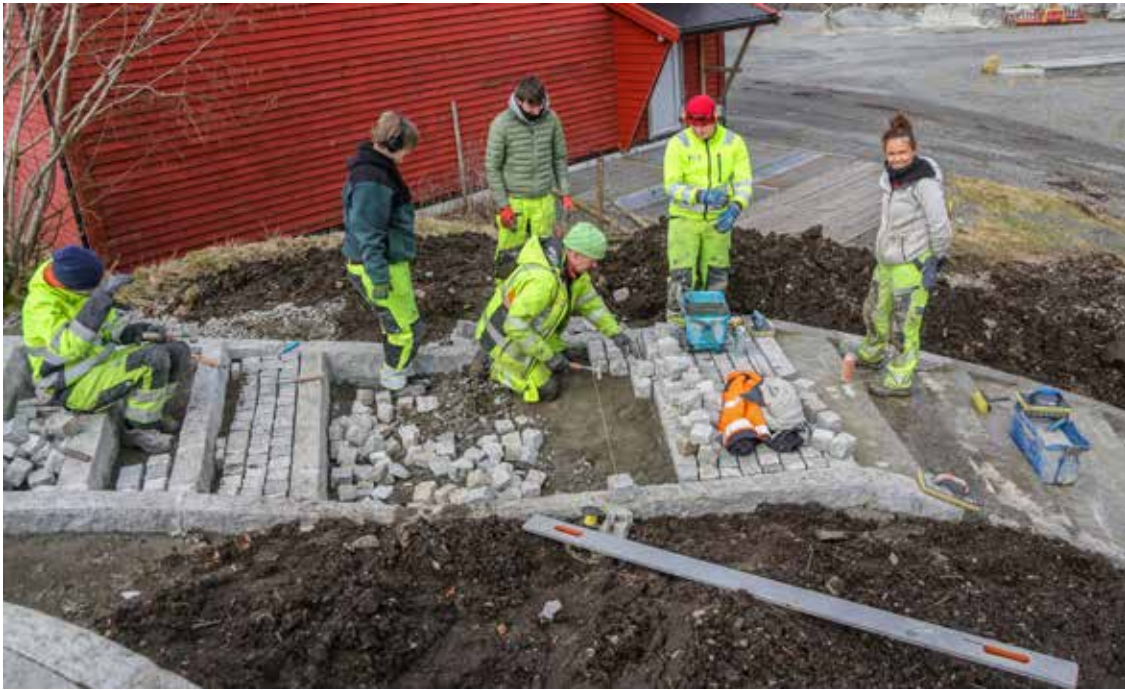
Vg2-elevene er i ferd med å etablere en fin uteplass med skiferheller, og mure opp en trapp med brostein og kantstein.
