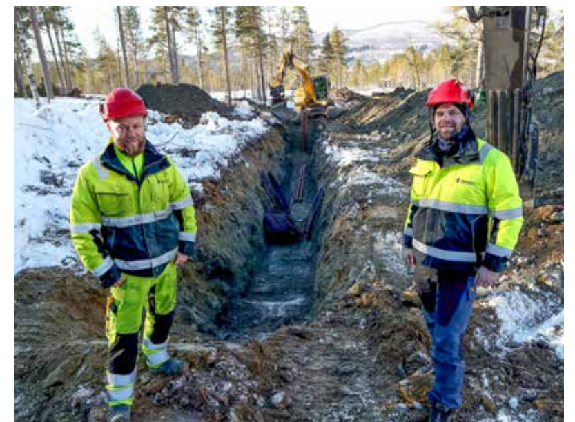
Bas Ivan Solheim (t.v.) og prosjektleder Mads Tamnes ved grøfta hvor Jon Erik Nygjelten fører gravemaskina i bakgrunnen.
