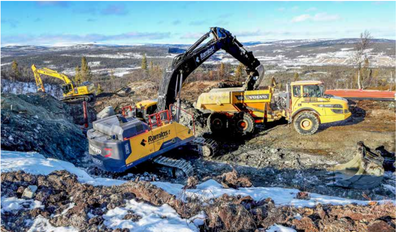
Tid for graving av grøft til vann og avløp til nytt hyttefelt inntil Hummelfjell hyttefelt i Os i Østerdalen.
