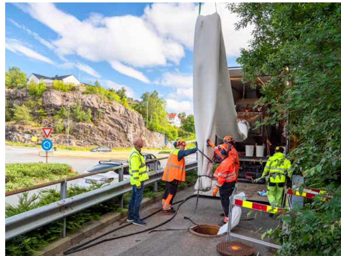
Gravefri ledningsfor-nyelse stanser ikke for trafikken. (Foto: Olimb Rørfornying)
