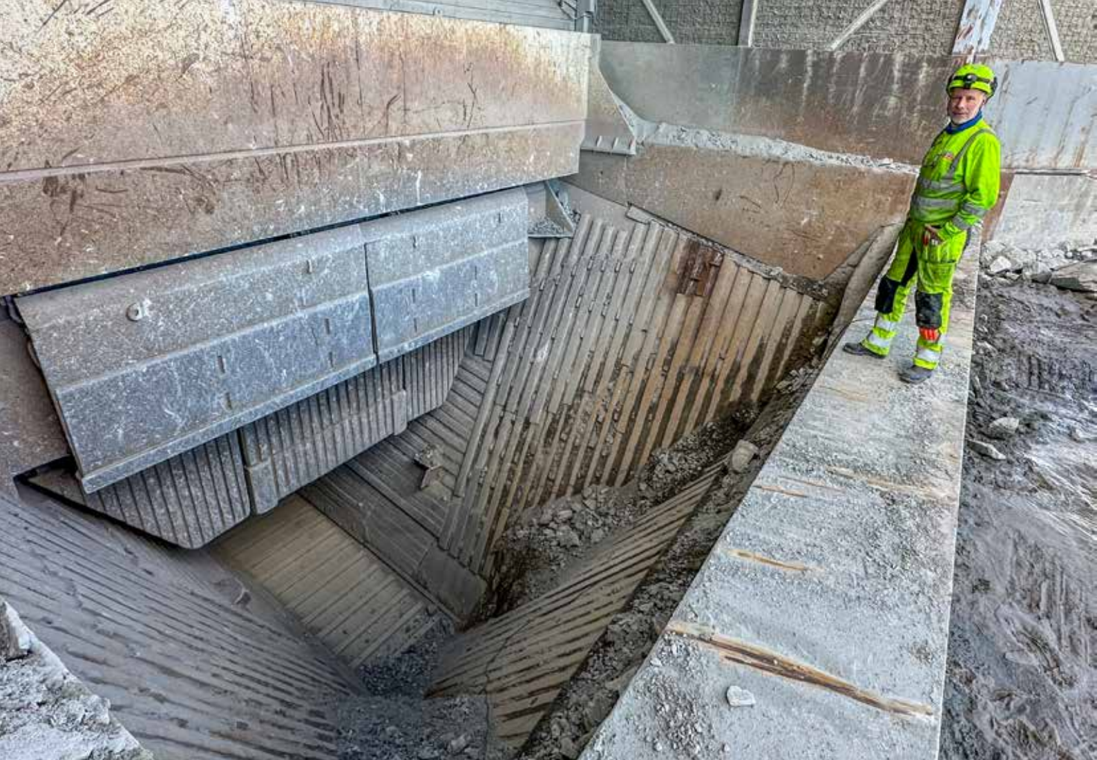
Det er store dimensjoner på utstyret hos Feiring. Sprengsteinen blir dumpet ned i denne tippettoa og fraktet videre på matebeltet ned i kjeftknuseren. Deretter går den videre til konknuseren.
