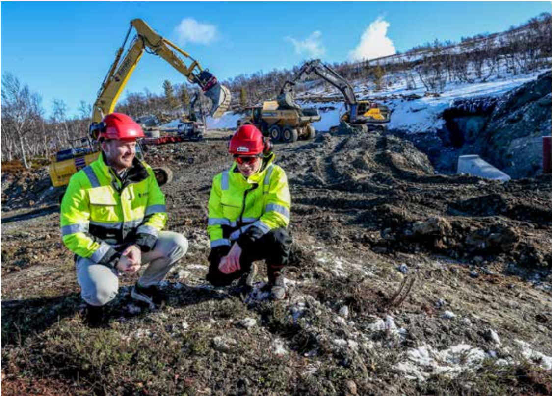
Her jobber Ramlos med VA i urørt terreng på fjellet i Os kommune i Østerdalen. Foran ser vi prosjektleder Bjørnar Høistad (t.v.) og anleggssleder Torjus Østgård.
