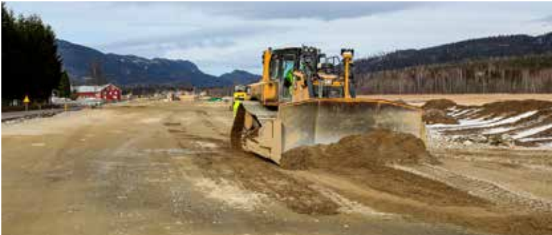
Her er maskinfører Ole Kristian Dahlen i bulldoseren i ferd med å avrunde en arbeidsdag på det som skal bli ny Rv. 3 ved Rogner gård i Stor-Elvdal i Innlandet.
