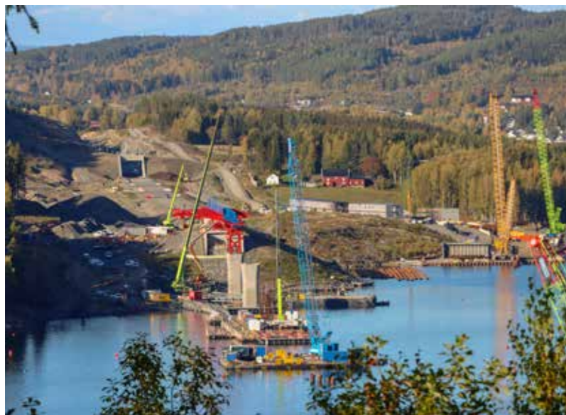
Med sine 1050 meter blir jernbanebroen over Tangenvika i Mjøsa Norges lengste jernbanebro. Rekordbroen skal støpes med en spesialdesignet støpevogn fra Kina.
