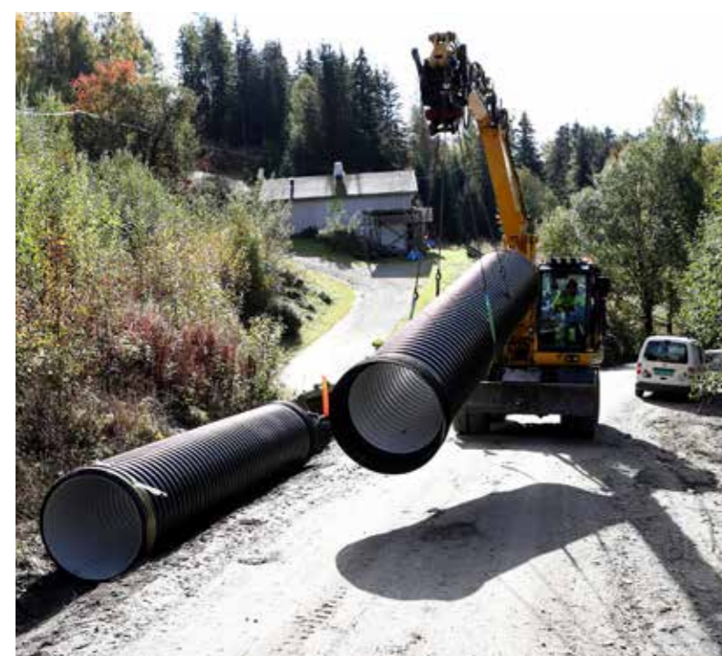
Torbjørn Weldingh kjører på plass nye rør med hjulgraver.
