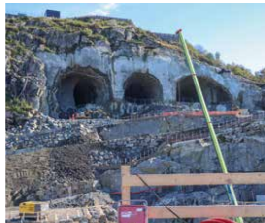
Det er flere tunneler i prosjektet. Her har Sartor & Drange bygget tilførselsveier og utfører wiresaging i tunnelåpningen til venstre på bildet.
