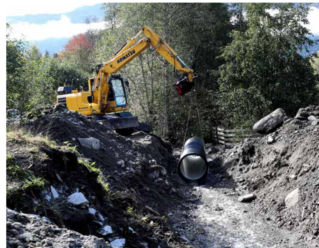
Torbjørn Weldingh heiser på plass det første nye røret nede i Slettingveien.
