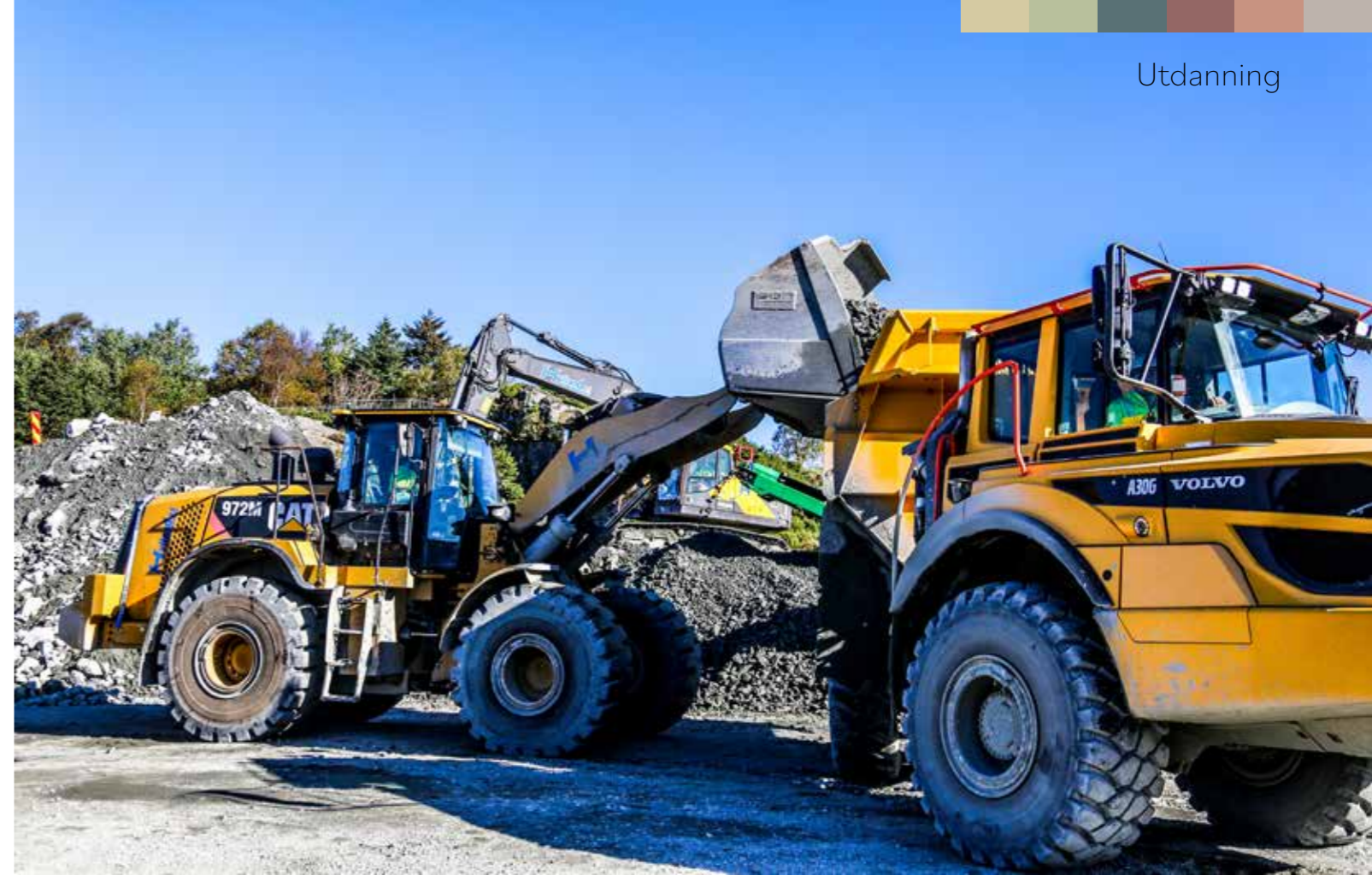
STØRST: Sotralink er den desidert største jobben Hylland AS har hatt, totalt sett. Flere av bedriftens lærlinger er også med på den omfattende veibyggingen.
