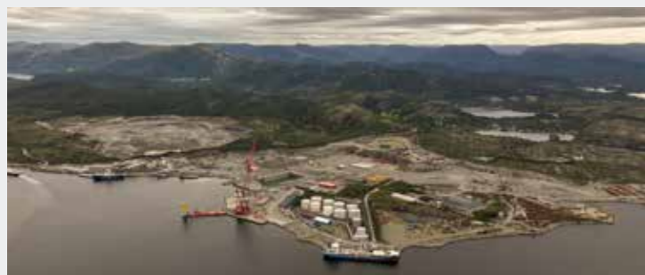
Wergeland Group holder til i Sløvåg, i Gulen kommune. Her har de et ca. 1500 mål stort anlegg som blant annet består av 2000 meter kai og stort steinbrudd. (Foto: Wergeland Group)
