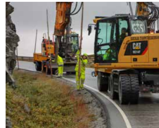
Arbeidslaget består av fem menn som har hver sin oppgave – pigge, sette ned brøytestikka, frakte sand, fylle sand i hullet rundt brøytestikka og sette på reflekstape.
