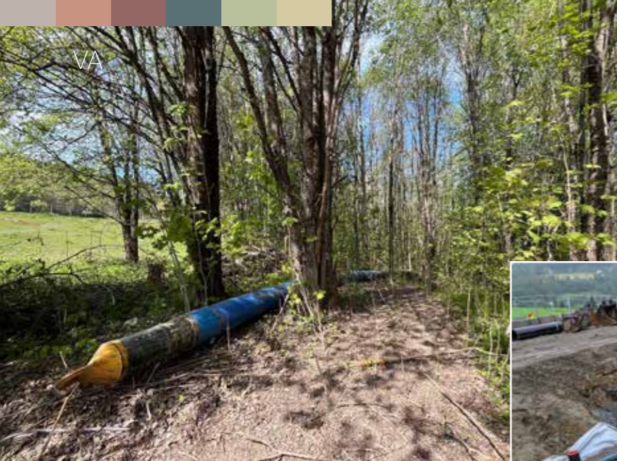
Det er lagt provisorisk vannledning under anleggsperioden. Denne her er trukket flere hundre meter gjennom skog og kratt av bergningsbilen som er avbildet på hovedbildet. (Foto: Tore Askilsrud/WSP)
