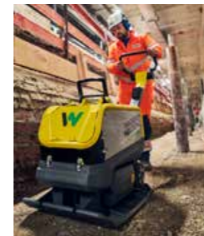
Til massekomprimeringen i grøfta ble blant annet den reverserbare vibrasjonsplaten APU3050e brukt.
