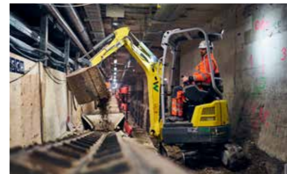
To batterielektriske minigravere av typen EZ17e var kontinuerlig i bruk på prosjektet.
