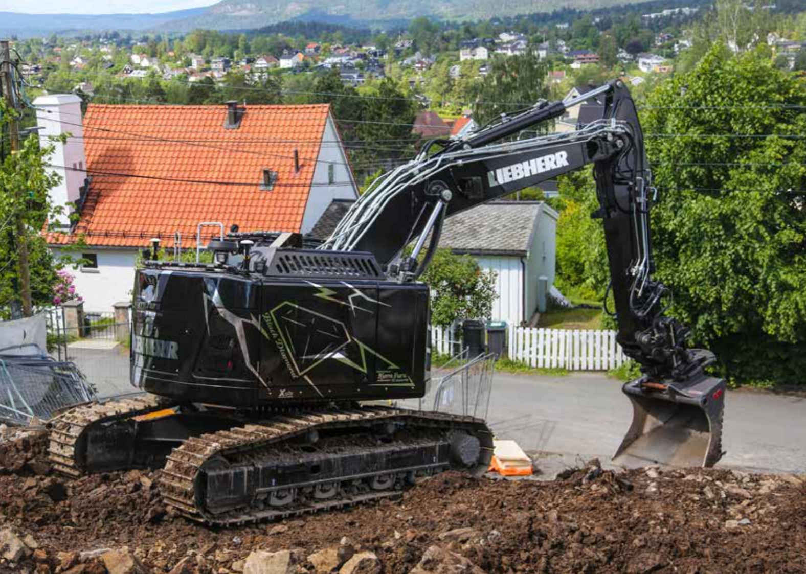
Maskinentreprenør Bjørn Furu er kjent for sine sorte gravemaskiner. På prosjektet på Røa var denne 40-tonns Liebherr 936 Compact i aksjon. Den har fått navnet «Black Diamond».
