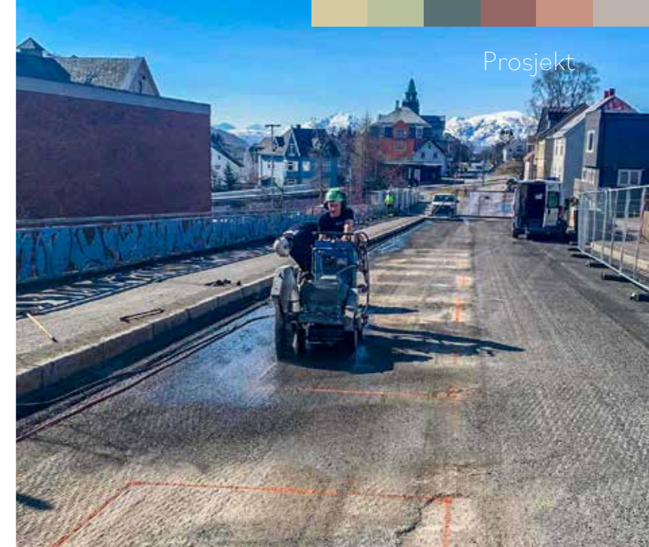
Her sages det hull i brodekket for å kunne montere forankringsklosser. Bildet er fra mai 2023. (Foto: Maskinentreprenør Herbjørn Nilssen AS)
