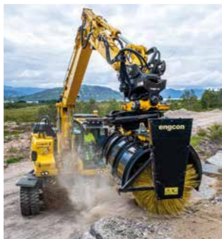
I hytta styres hele herligheten med DC2 styresystem gjennom skjermen med Trimble Earthworks, mens Jan-Kenneth kontrollerer alle funksjoner gjennom Engcon MIG2 spaker.
