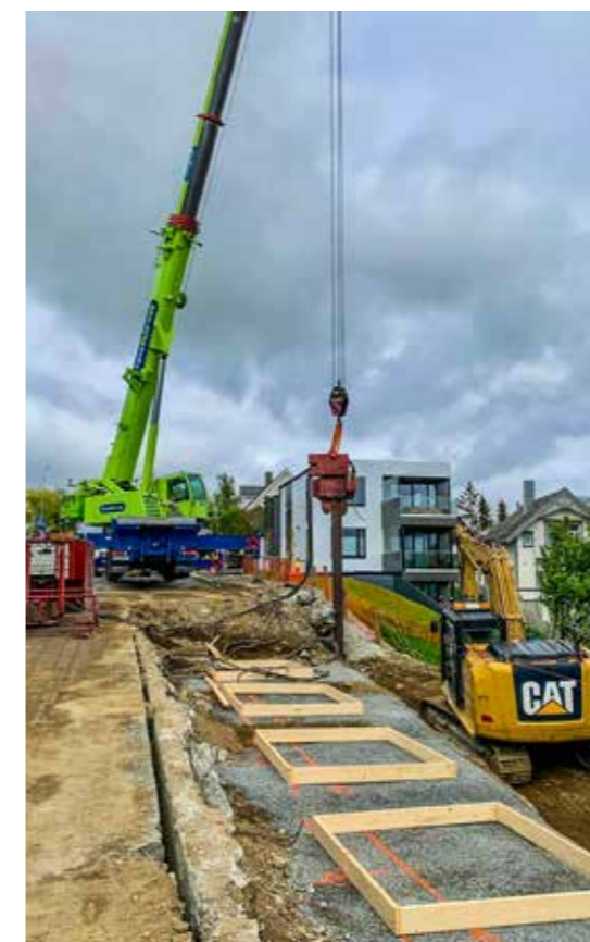
Bildet er fra juni i fjor. Her er første spuntnål satt ned. Hele linjen er forberedt for spunting, og første del av den gamle brokonstruksjonen er revet. (Foto: Maskinentreprenør Herbjørn Nilssen AS)
