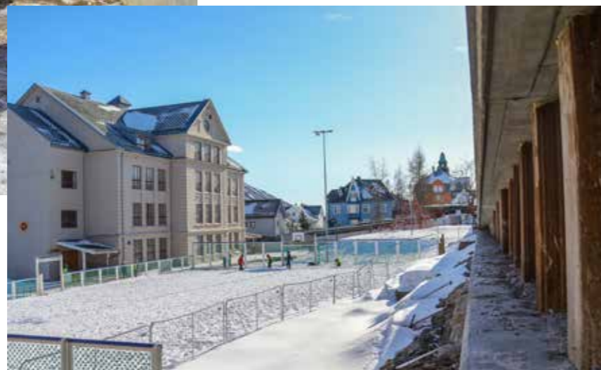
Her ser vi hvor nærme skolen og skolegården ligger anlegget. Entreprenøren har sikret anleggsområdet underveis i prosjektet, med både gjerder og vakthold.
