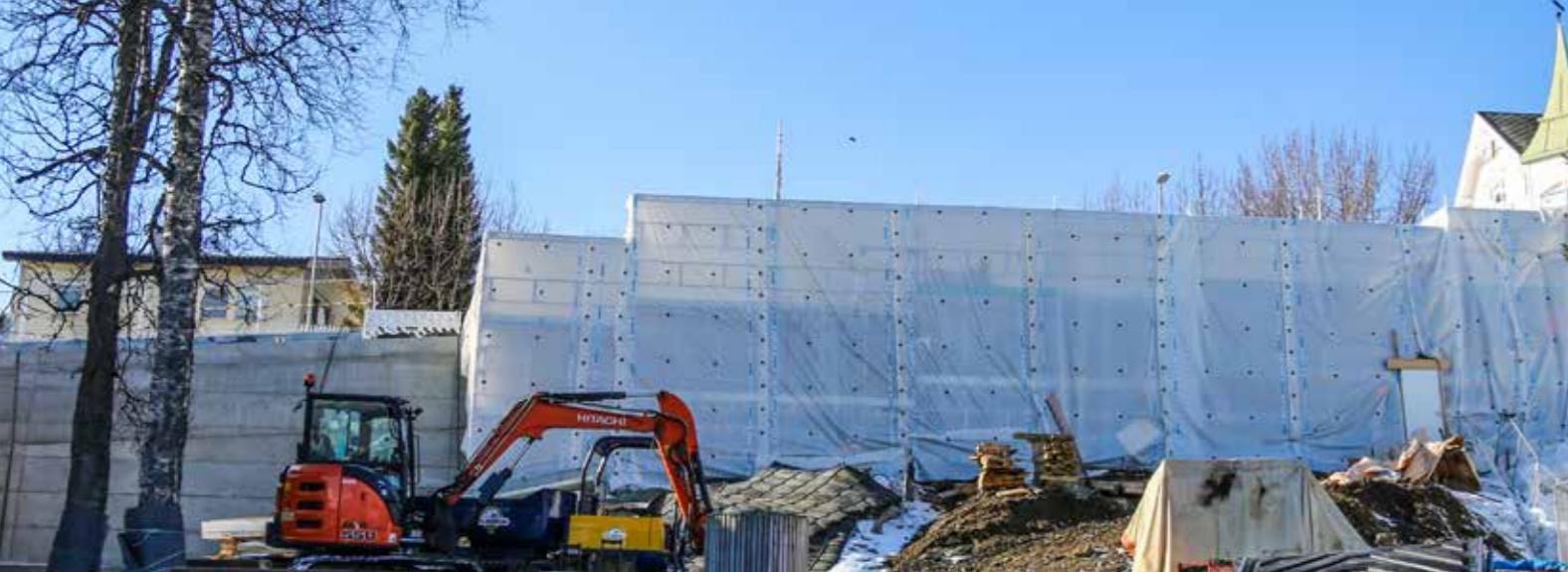
Da Anleggsmaskinen er på besøk i april, er spuntveggen ferdig for lengst, og entreprenøren holder på med å støpe betongen. Det foregår inne i et stort telt, for å holde temperaturen for støping oppe når det er kaldt ute.
