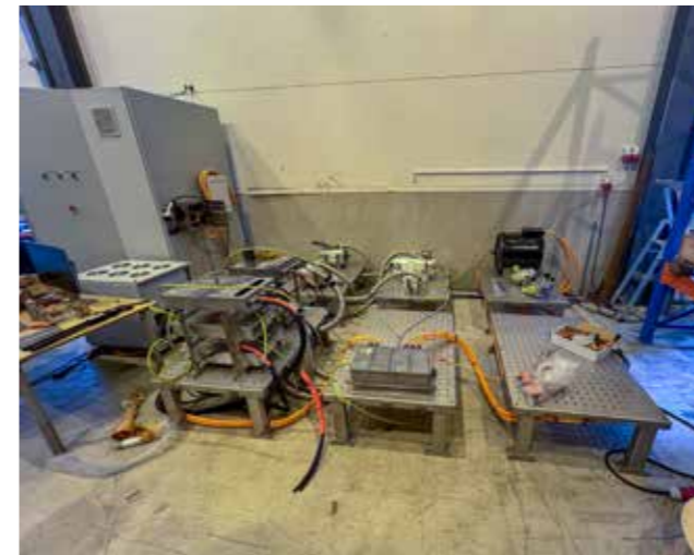
Her testes styresystemer, el-motorer etc. før de skal monteres i maskinen.
