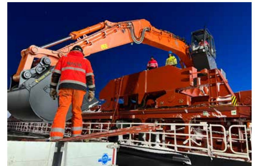
En båtmaskin krever mange timers arbeid både før ombordlasting og under montering. (Foto: Nasta)
