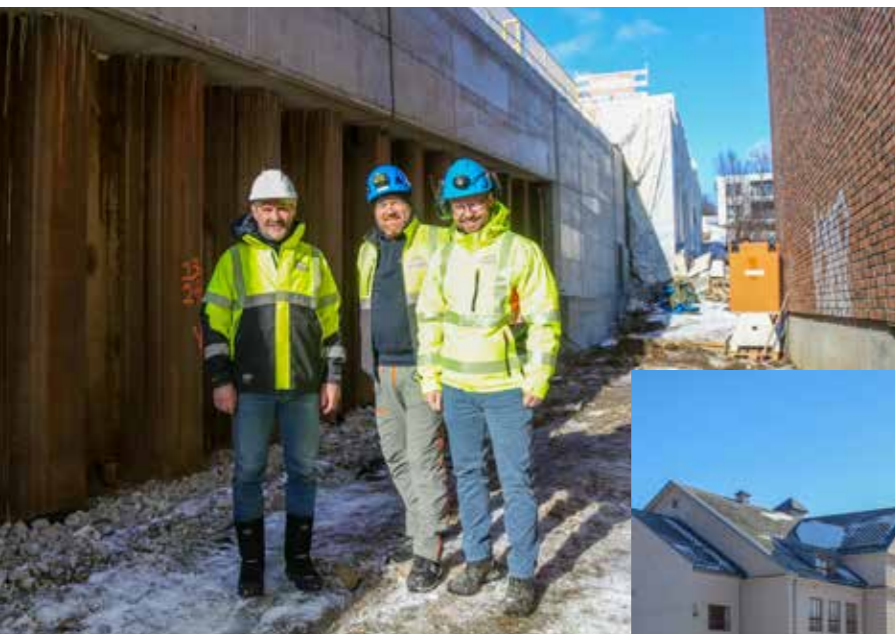
Herbjørn Nilssen (fra venstre), Pål Robertsen og Nicolai Kulseng-Varmedal foran spuntveggen. Øverst er betongen ferdig støpt. Til høyre på bildet ser vi skolens turnhall. Det er nettopp fordi denne delen av spuntveggen skjules av hallen og skolen at den ikke helstøpes.
