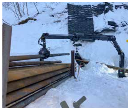
Hver borstang er 9,6 meter og løftes på plass med kranen som er montert på boreriggen. (Foto: Bortech)
