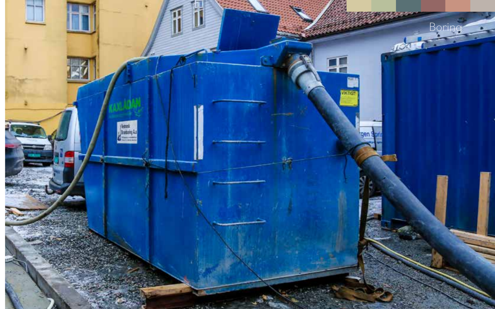
Alt av vann og boreslam går gjennom sedimenteringscontainere. Først en lukket sedimenteringscontainer, og deretter en åpen container. Boreslammet kjøres til godkjent deponi.
