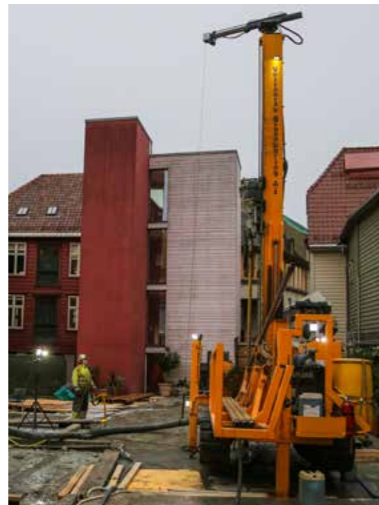
Det er generelt trangt og kronglete inne i sentrum, og det skal være minst 15 meter mellom hvert hull.
