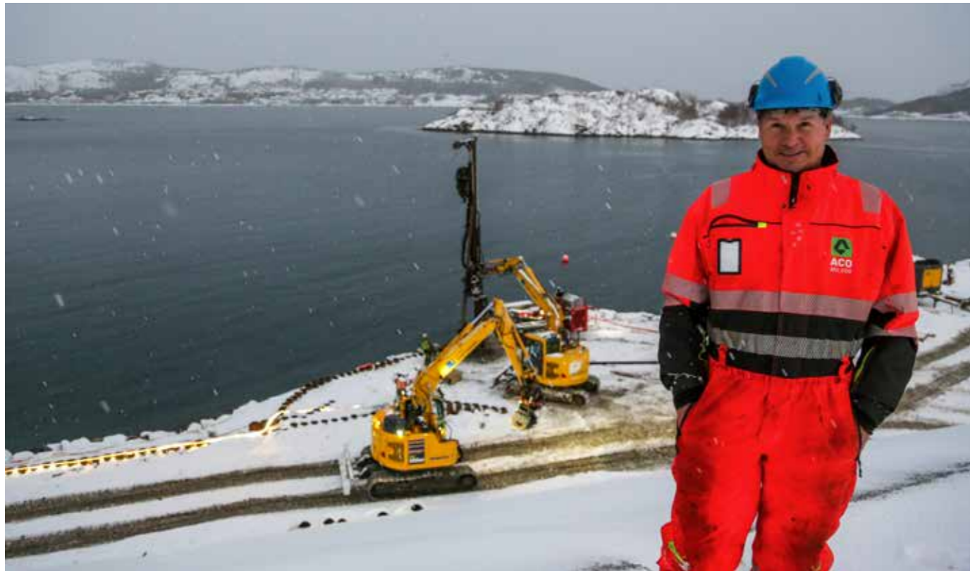
Det er ikke så lett å se med all snøen på bildet, men det er om lag 10 meters høydeforskjell fra øvre del av tomten, der prosjektleder Asle Drabløs i ACO Anlegg står, og ned til sjøen, der maskinene befinner seg.
