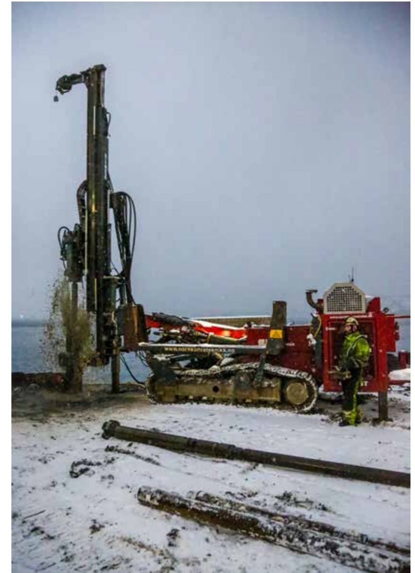
Dybden på rørsputen varierer fra 5 til 30 meter, og rørene har en diameter på 280 mm.
