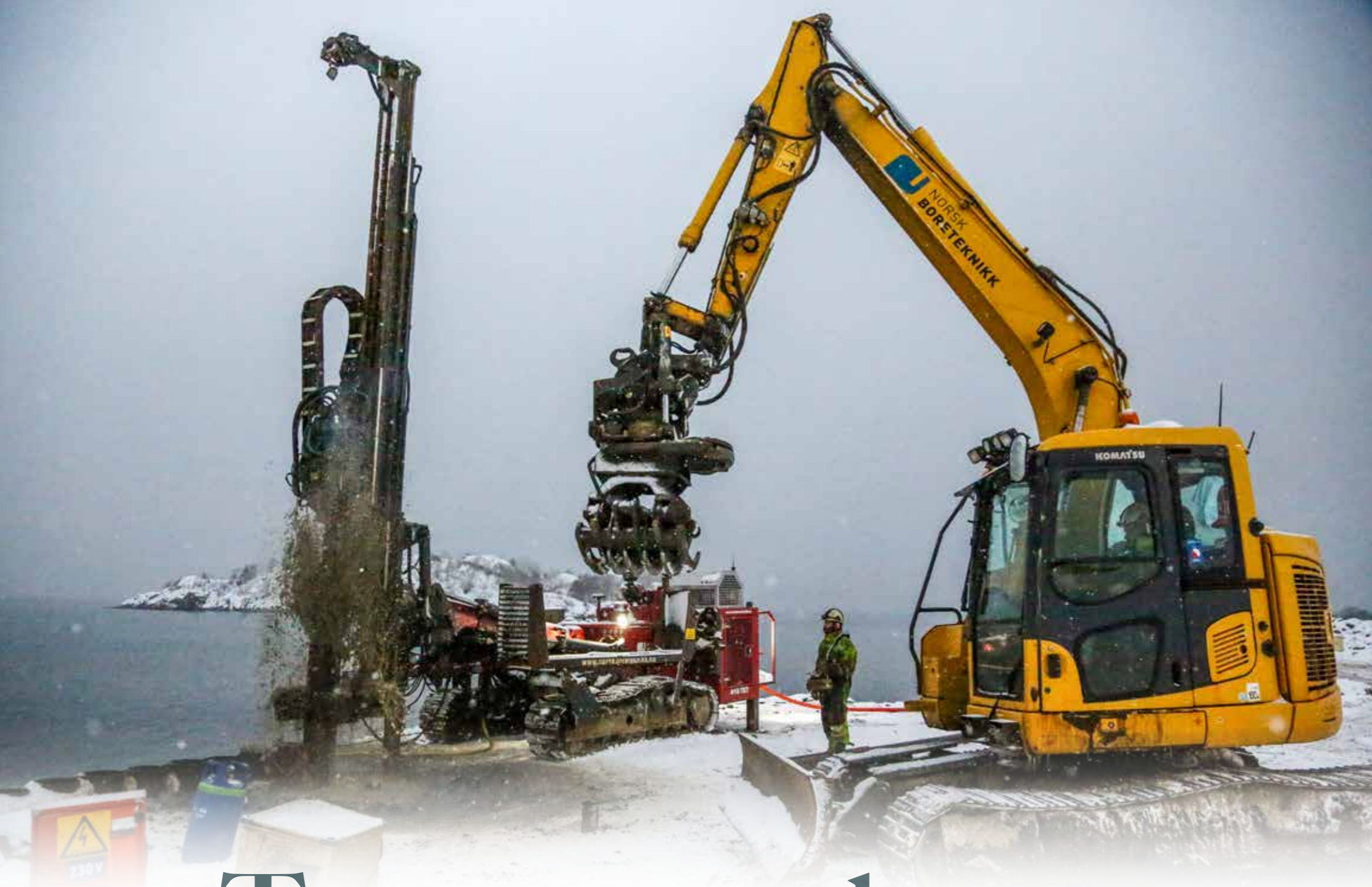
Dybden på rørsputen varierer fra 5 til 30 meter, og rørene har en diameter på 280 mm.
