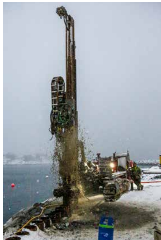
Da Anleggsmaskinen er på besøk er ca. 80 prosent av spuntveggen ferdigstilt.
