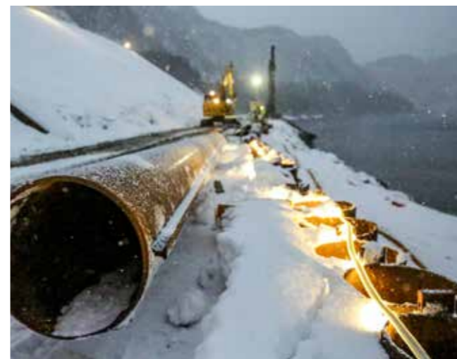
Spuntrørene hektes sammen i en slisse – som not og fjær – slik at det blir helt tett, og det blir også gyst ned i slissene.
