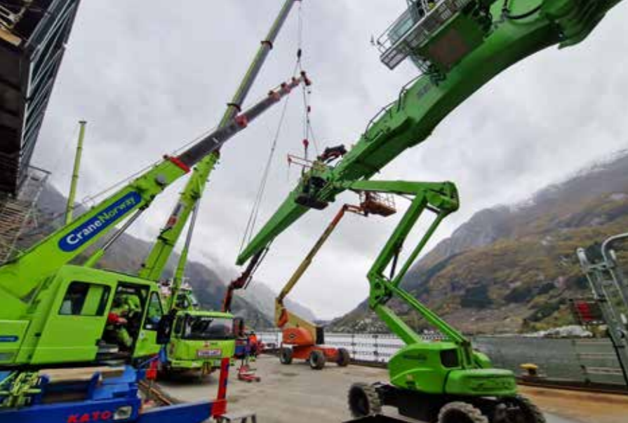
Fra monteringen av bom og stikke på Sennebogen 885G. Tre kraner og to lifter måtte til for å få dem sammen. (Foto: Stuart «Spike» Hoggart)
