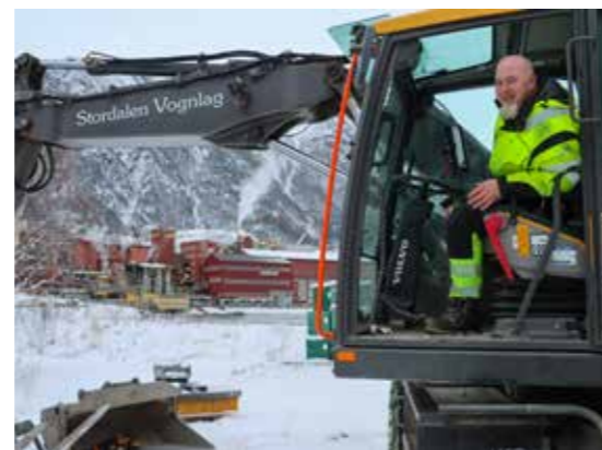
Lars Jørgen Stålesen i Stordalen Vognlag AS og hans Volvo EWR150E hjulgraver, har vært leid inn av Volvo Maskin for å bistå i maskinføreropplæringen av de ansatte i Boliden Odda.
