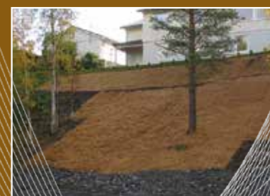
Erosjonssikring ned kokosnett i Gjerdrum
