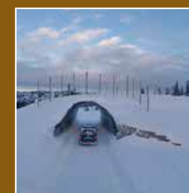
MP200 trafikk tunnel under skiløype på Kvittfjell.
