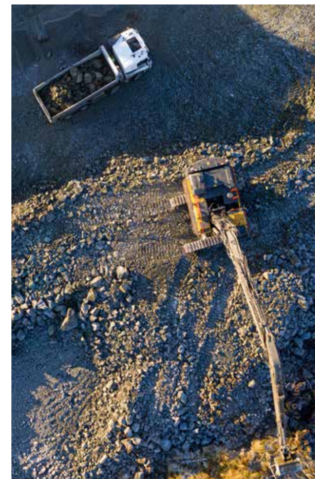
REKKEVIDDE: Sartor Maskin AS sin nye Volvo 480 HR langgraver rekker 19 meter ut. (Foto: Jørn Søderholm)
