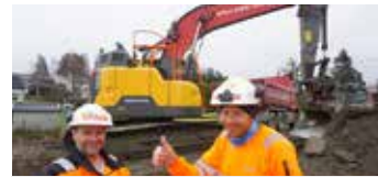
Sentrumsveien Vestby med alle våre fagområder involvert
