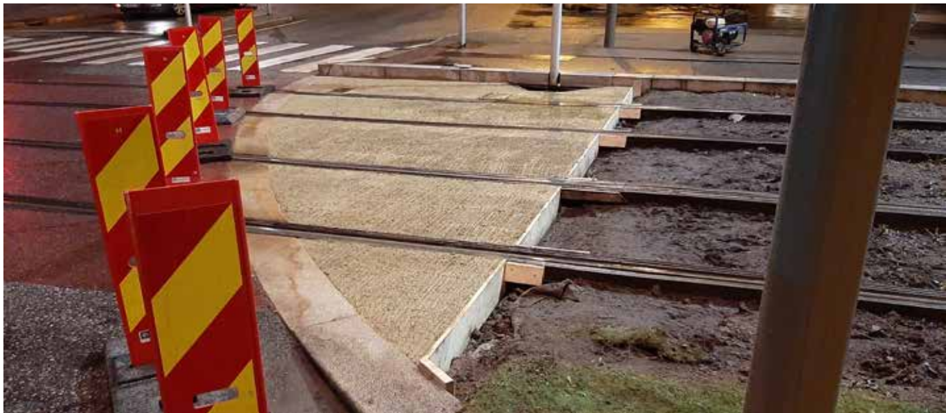
BETONGPLATE: En av oppgavene på fagprøven var en støpejobb på begge sider av holdeplassen. Her er det akkurat støpt ferdig på den ene siden. (Foto: Cato Remme).
