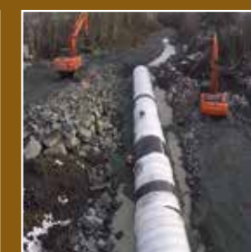
TrenchCoat rør under vei på Verdal.
