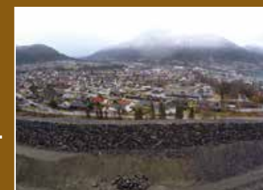
Jordarmoring av rassikringsvoll i Ørsta
