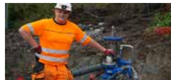
Vi fornyer vann og avløp på prosjektet VA Næringsrød i Halden
