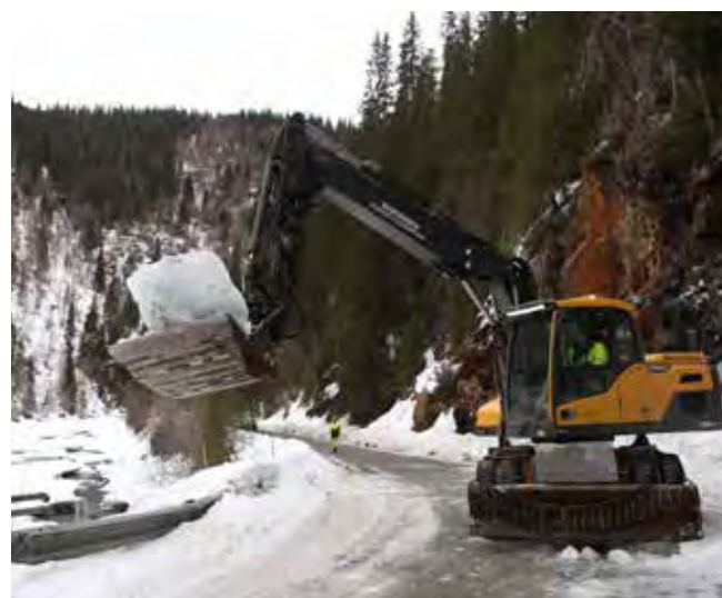
SKUFFE: Tor Inge Kvernmo bruker bred skuffe for å løfte isen over til den andre siden av veien og ned skråninga mot elva.
