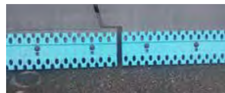
DETALJ: Slitestål trenger ikke skråningskjevning ved utskifting.
