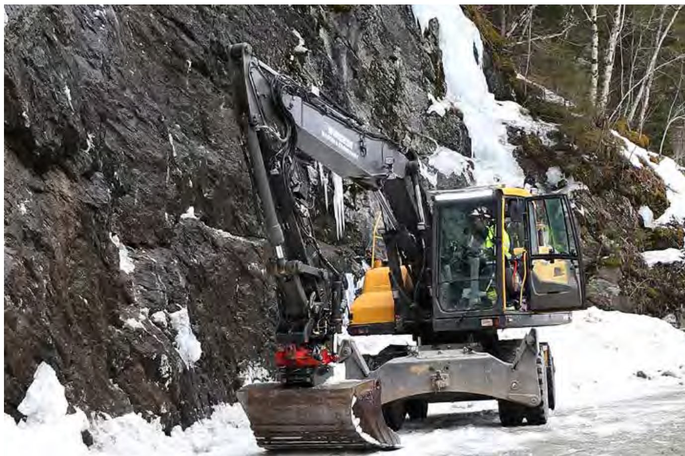
UTFØRT: Her er jobben utført. Litt is står igjen øverst på grunn av fare for ras. Kvernmo har også lagd ei grøft med gravemaskina, slik at vannet skal renne dit det skal.
