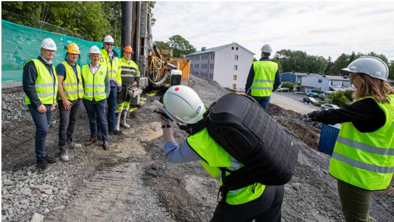
BEFARING: Her bygges 1,4 km gang- og sykkelvei i Lysaker utenfor Oslo. En stor vannledning går under veien, og Brødrene Myhre AS borer pæler for å hindre utglidning.
