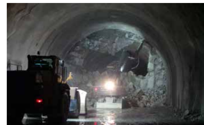
GJENNOMBRUDD: Implenia driver i hovedsak med tunnelpigging. (FOTO: EGET)
