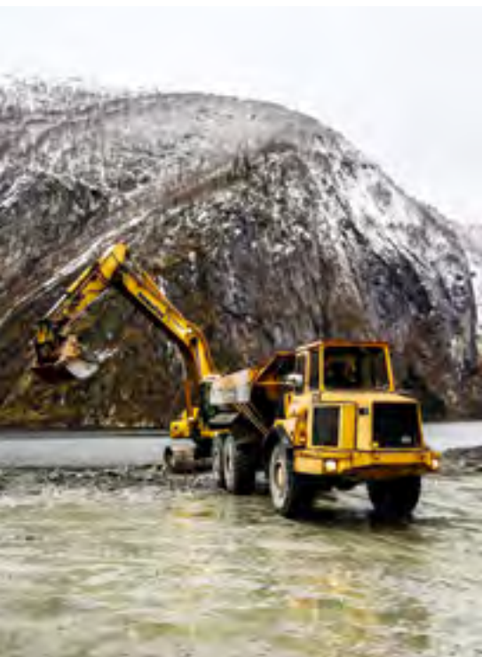
IKKE BARE I FJORDEN: Vanligvis blir sprengstein på Vestlandet bare lempet ut i den brådype fjorden. På dette prosjektet blir derimot noe av overskuddsmassene brukt til lokale formål.
