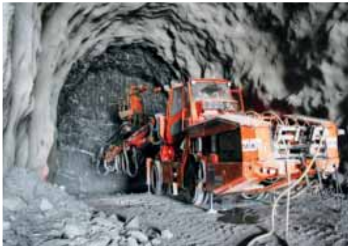
Steintoft Boreriggen i aksjon.
