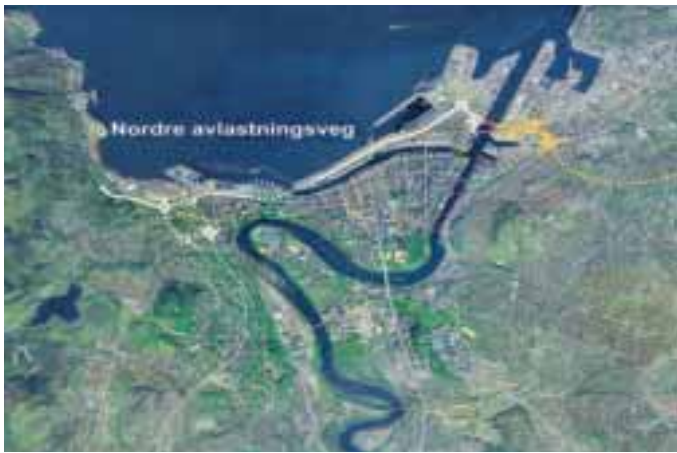
Oversikt 2 Oversikt over E6 Nordre avlastningsvei.
