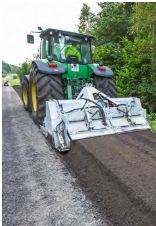
FRES: Nå kjører valse etter Crusher Internationals egenutviklede fres. (FOTO: JØRN SØDERHOLM)
