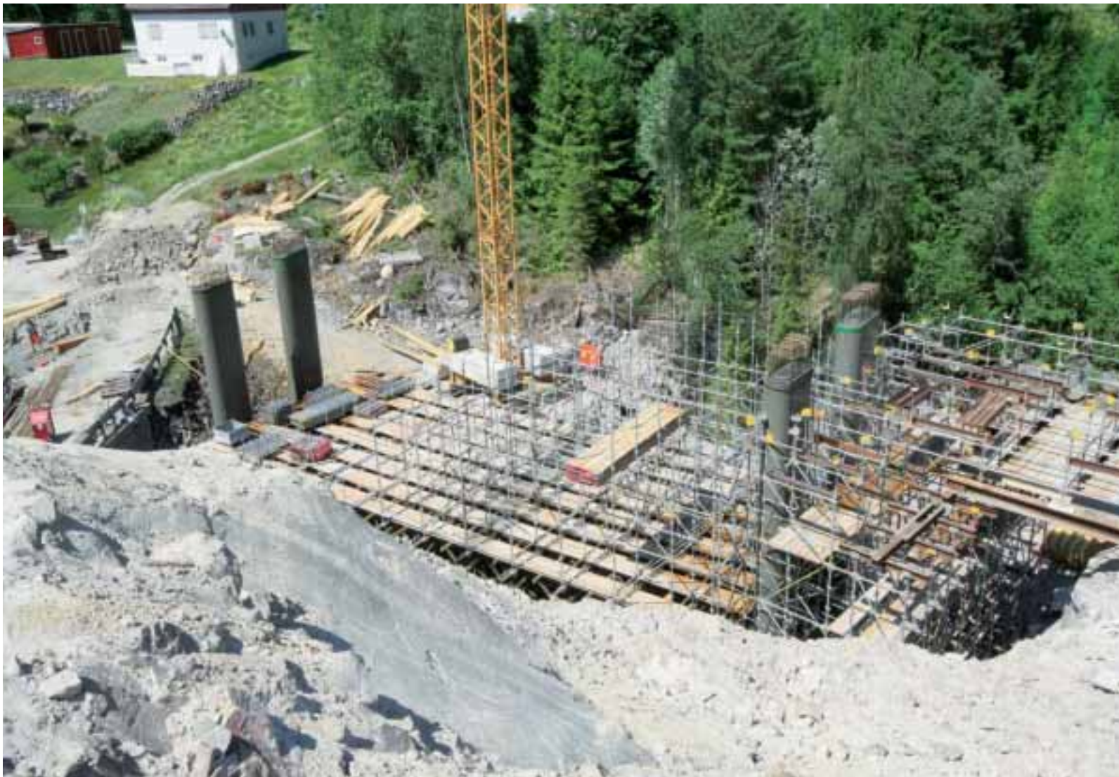
Erstatning Helt nye Hjukse-elva bru med spennmålene 16-24-16 meter skal støpes rett etter ferien.
