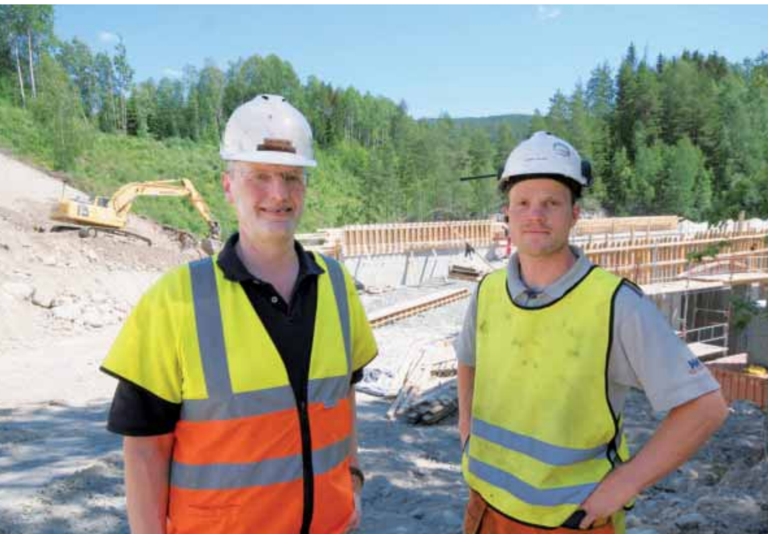
Leder an Hallgeir Lie (t. h.) og Erlend Solheim styrer arbeidet med det største veianlegget i Telemark dette året.
