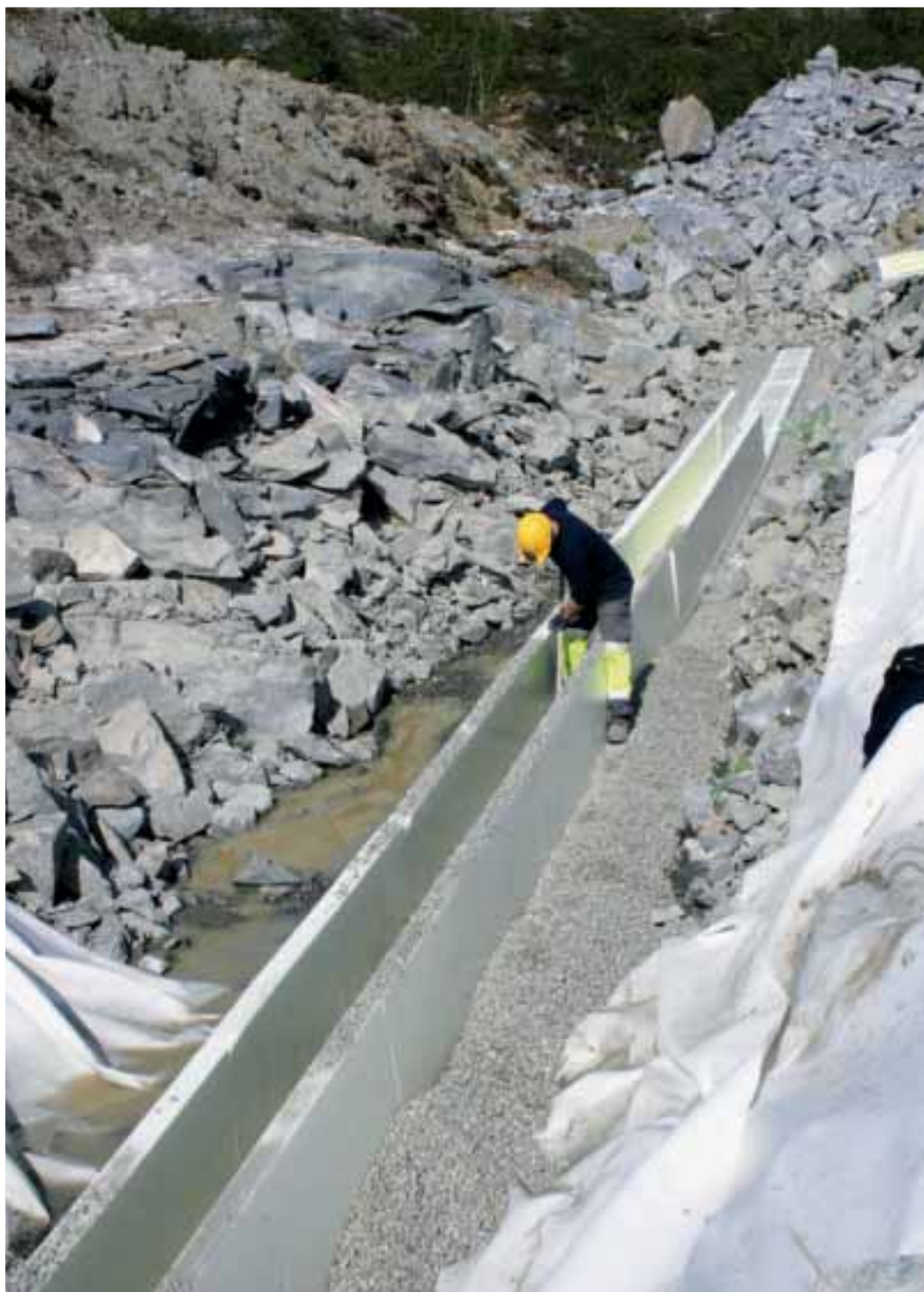
Kabelgrøfter Full aktivitet på anleggsplassen.
