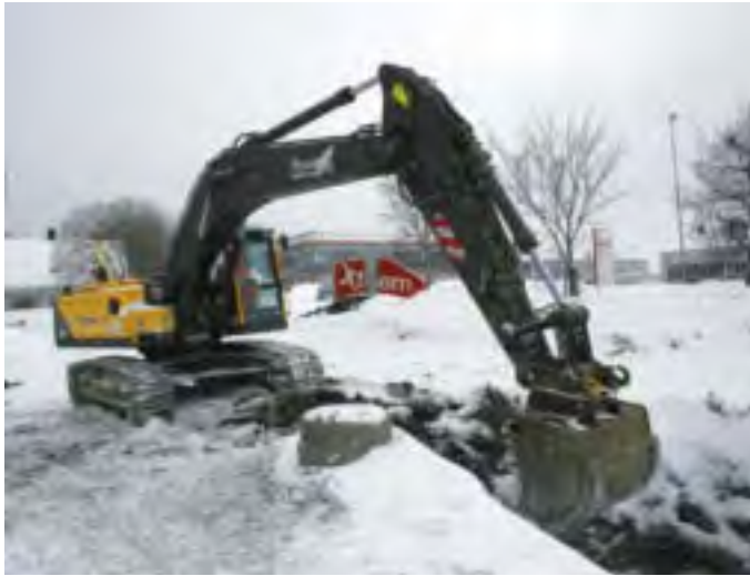
Kald jobb Grøftarbeider i forbindelse med legging av nye vann- og avløpsrør.
