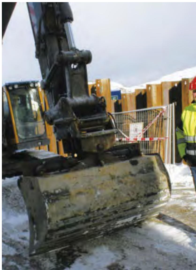
Inn og ut ”Vi er først inn og sist ut fra byggeplassen,” sier H. & O. Bernhardsens prosjektleder, Kristian Bernhardsen.
