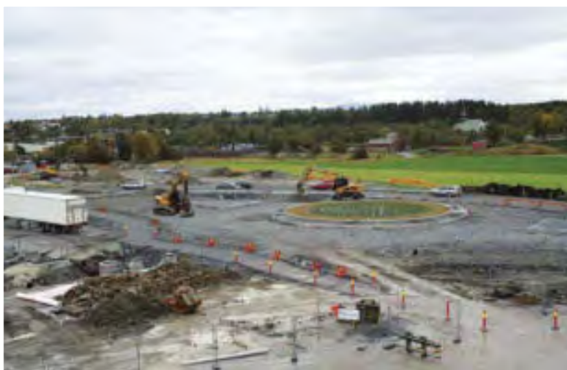
Omkjøring I forbindelse med byggingen av ny rundkjøring, ble det etablert en midlertidig omkjøringsvei. (Foto: Alstad Maskinbedrift AS).
