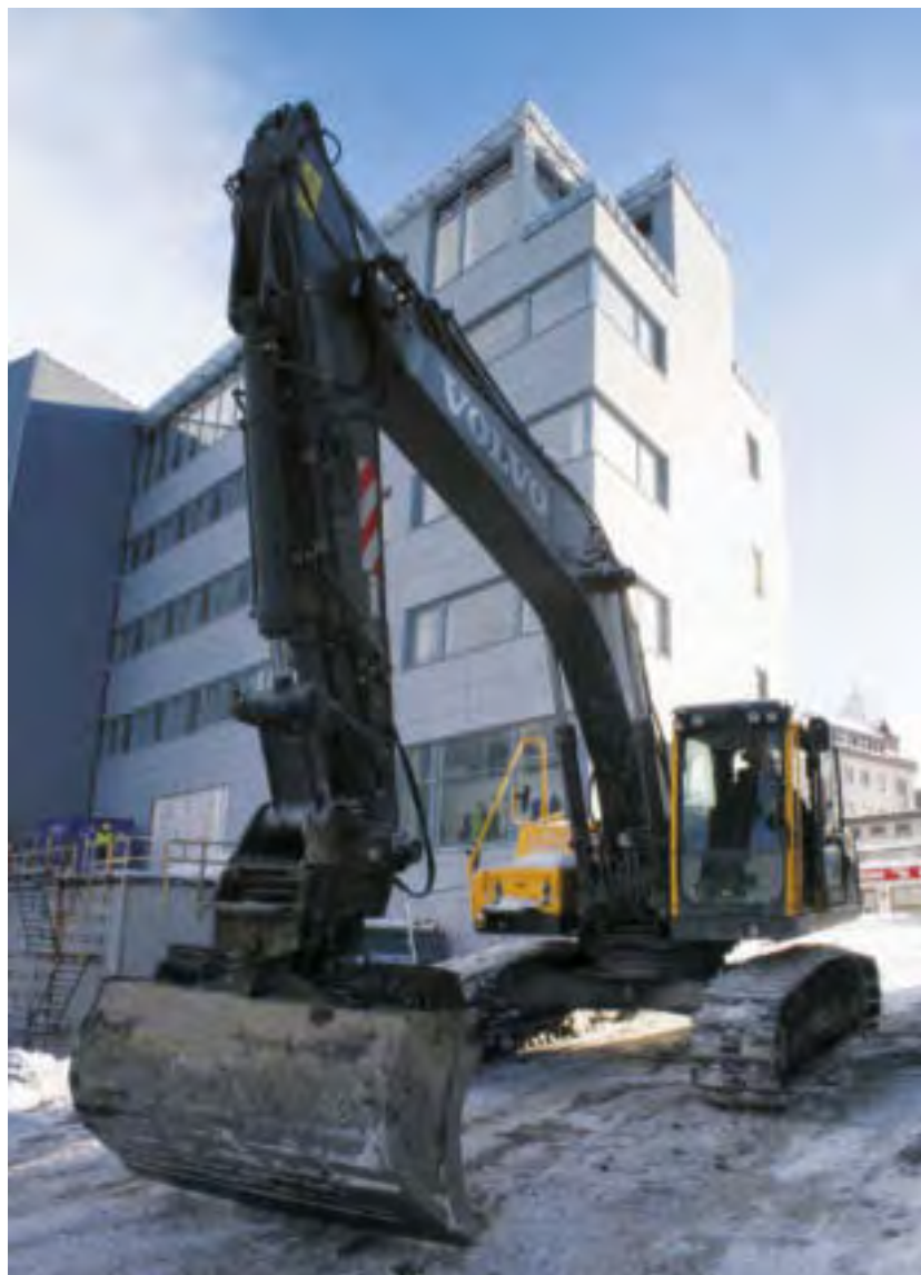
NAV Luftfartstilsynets nye hovedkontor vil ligge nesten vegg-i-vegg med NAV-bygget, som man kan se bak gravemaskinen på dette bildet.
