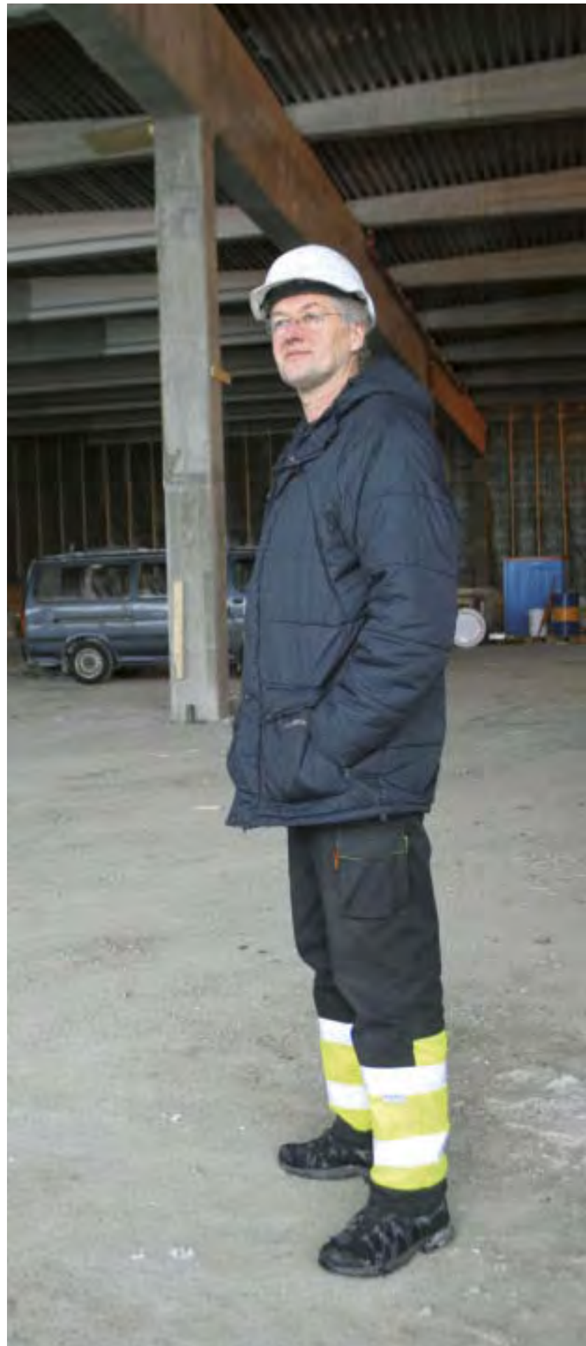
Stor rivejobb Prosjektlederen inne i det gamle NKL-bygget, hvor alt innvendig ble revet helt ned.
