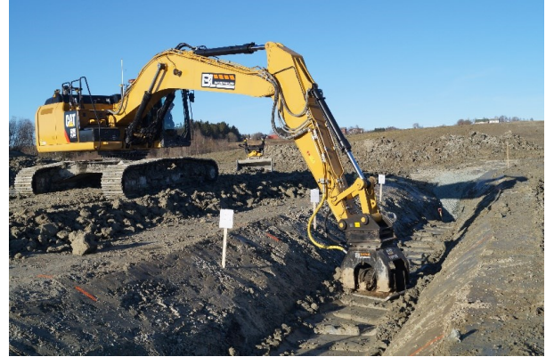
Figur 22 Komprimering av leire i grøft. Foto: JMSH
