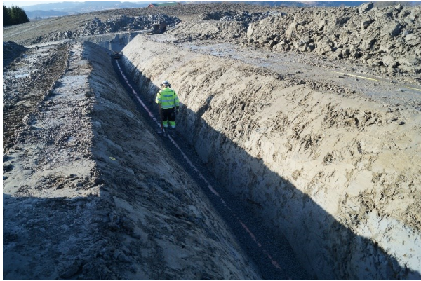
Figur 21 Legging av rør i grøft. Foto: Enoch By
